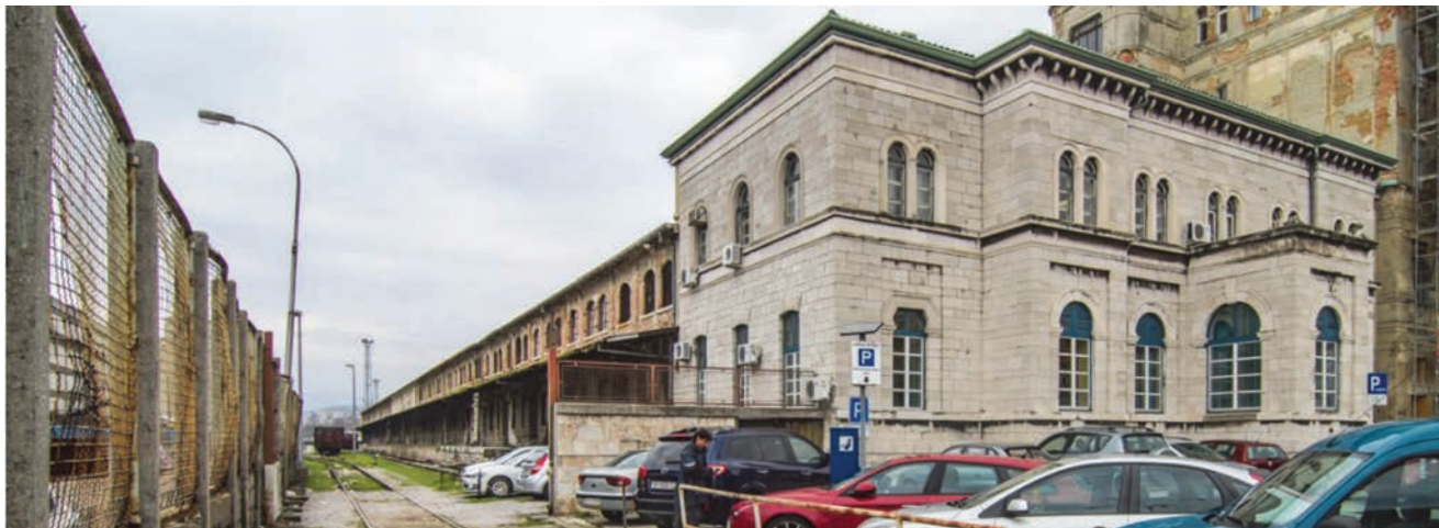
Skladište IIIb s pročelnom zgradom
