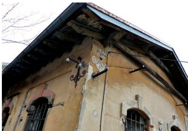
Detalj glavnog pročelja zgrade
