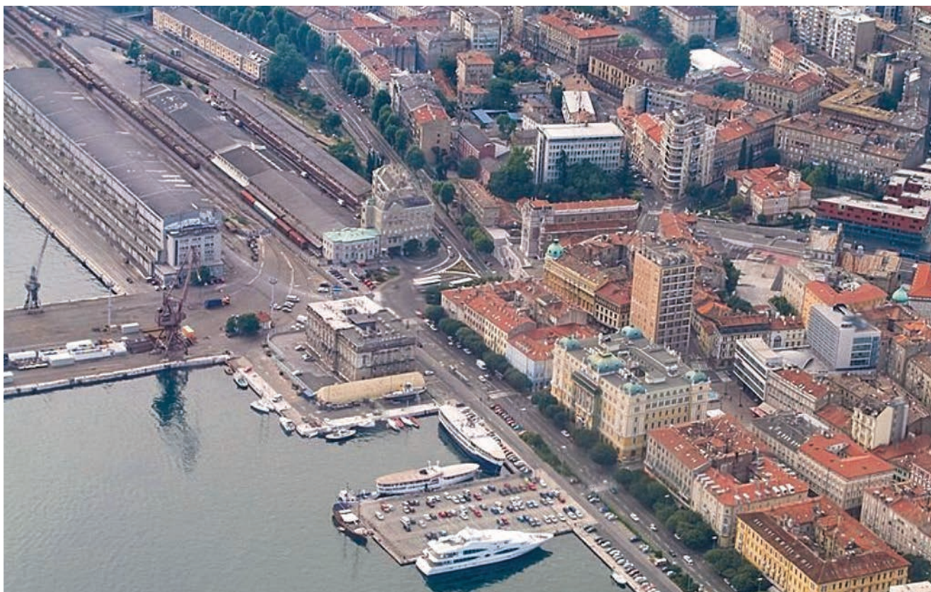
Pogled iz zraka na usporedna skladišta IIIa i IIIb
