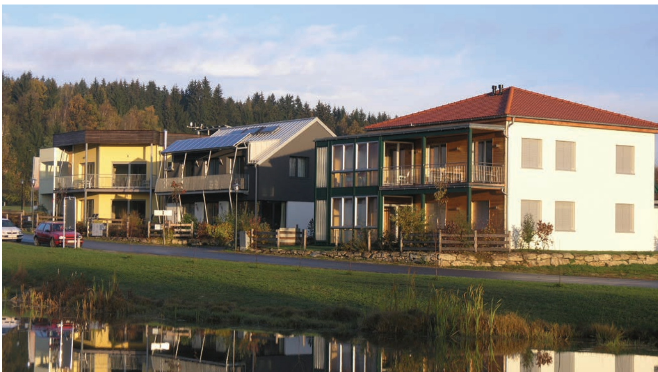
Naselje pasivnih kuća Sonnenplatz u Großschönau u Austriji
