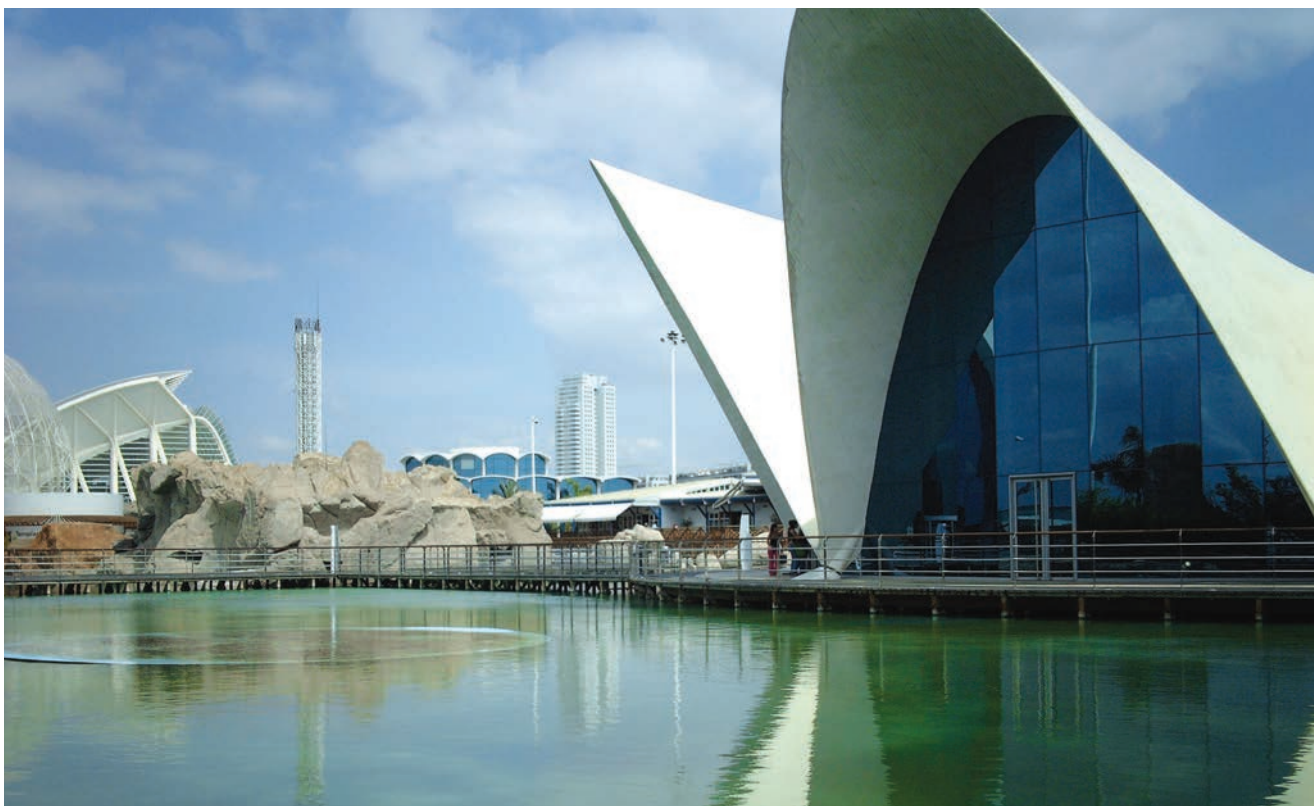
Zgrada oceanografskog parka l'Océanogrâfic
