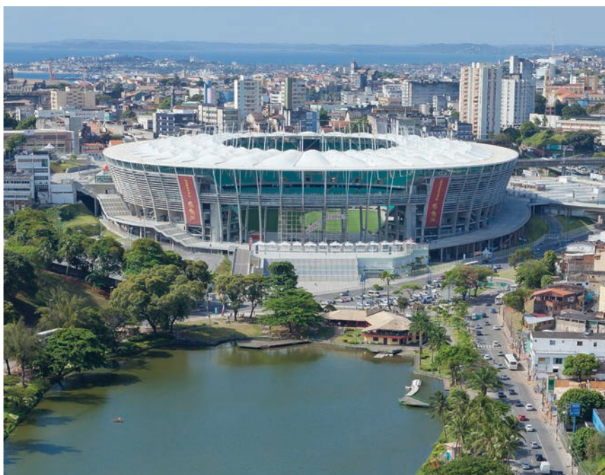
Stadion Arena Fonte Nova snimljen s jezera
