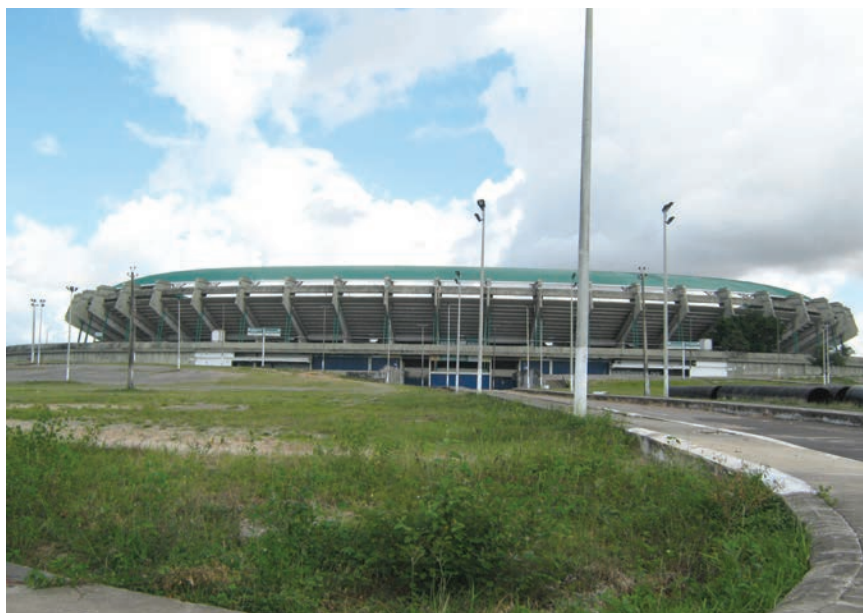
Stadion Castelão u Fortalezi tijekom obnove
