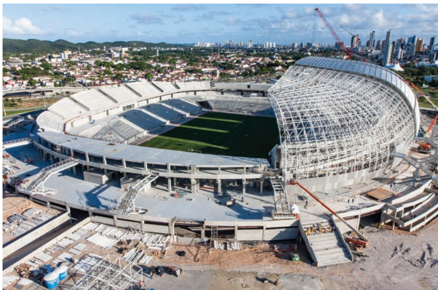
Gradnja stadion Arena das Dunas u Natalu
