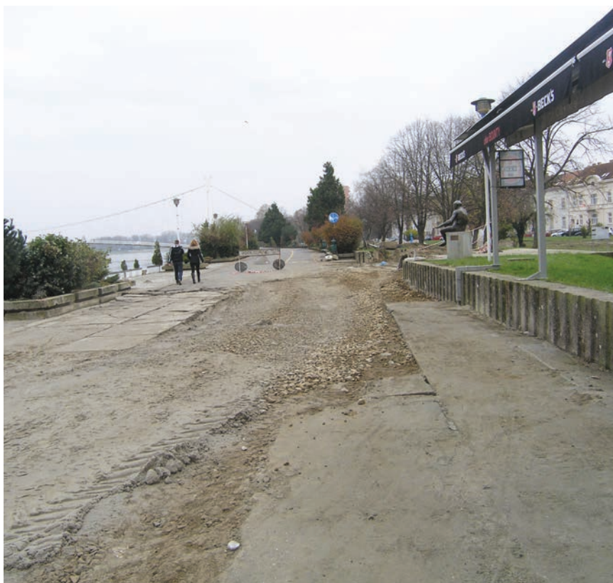
Dio obale gdje su kanalizacijske cijevi već ugrađene
