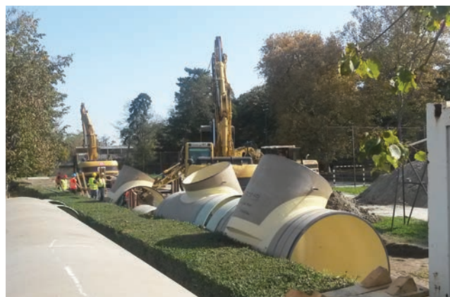
Početak ugradnje kanalizacijskih cijevi u novi sjeverni kolektor
