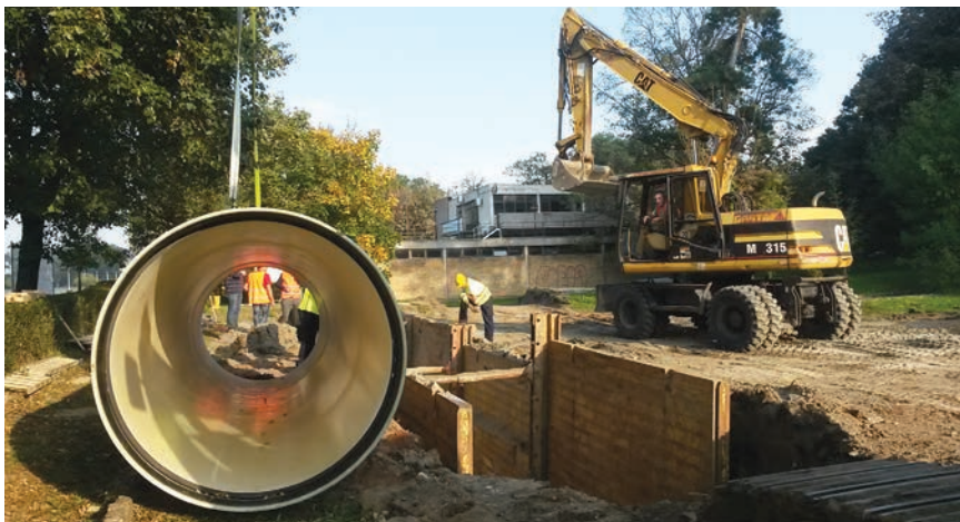
Cijev pripremljena za ugradnju
