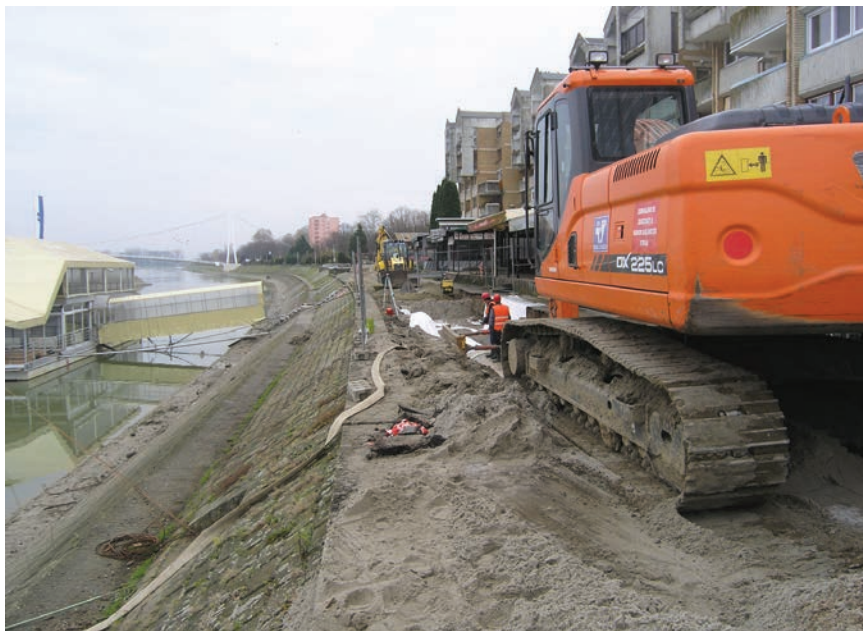
Intenzivni radovi na obali
