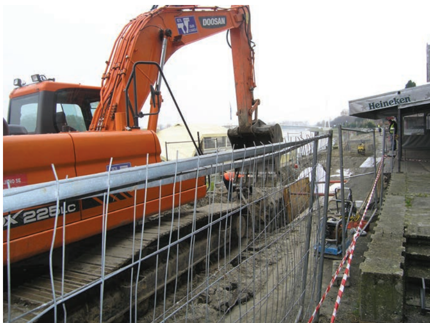
Detalj ugradnje kanalizacionih cijevi u središtu Osijeka
