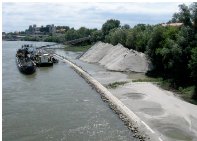
Radovi na uređenju dijela obale tijekom projektiranja
