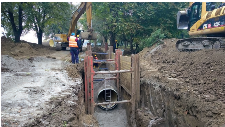
Ugradnja cijevi u zelenilu pokraj Drave
