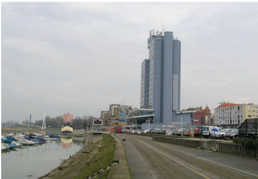
Gradilište na obali zimske luke i Drave tijekom posjeta
