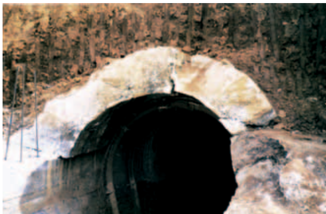
Injekcijska galerija nakon završenog iskopa
