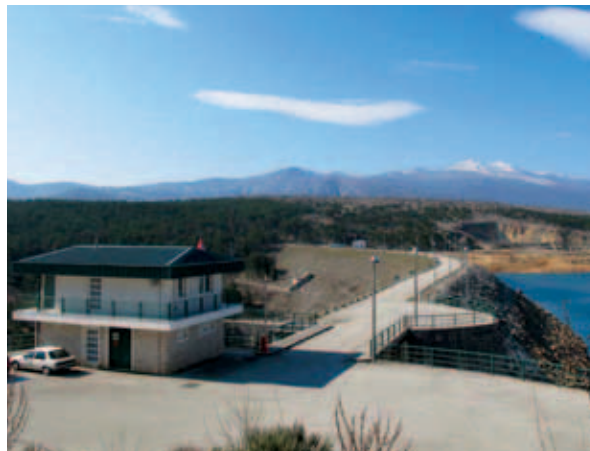
Obnovljeni lijevi dio brane
