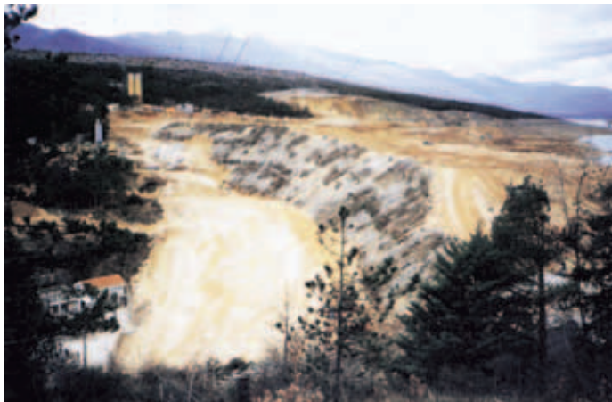
Ugradnja kamenog materijala u nizvodnu potpornu zonu brane
