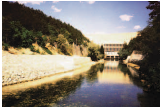
HE Peruća nakon obnove brane
