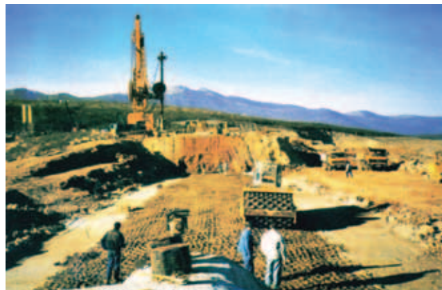
Izvođenje glinenobetonske dijafragme
