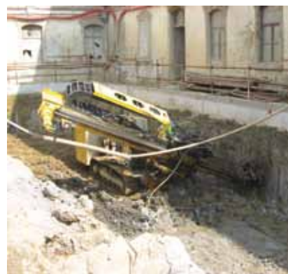
Radovi na iskopu i zaštiti građevne jame
