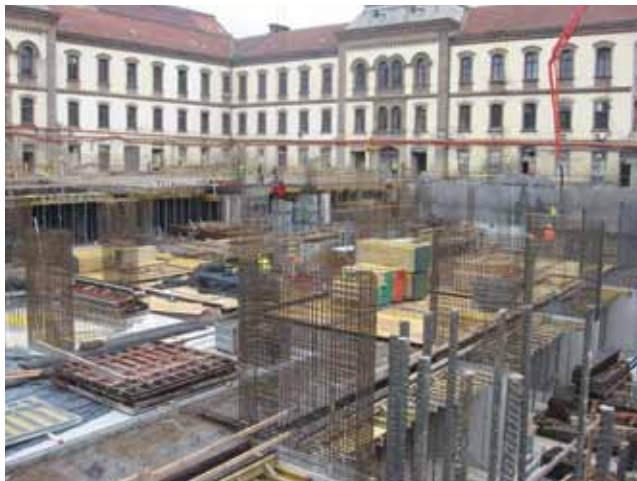
Izgradnja podzemnog dijela građevine
