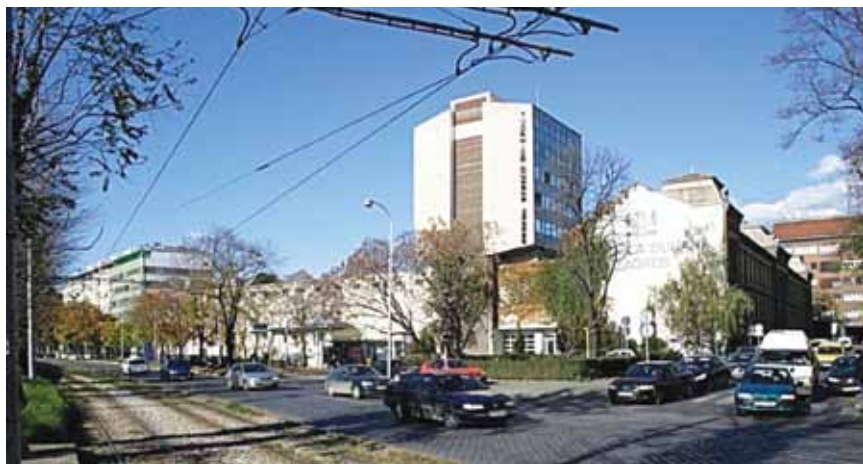
Južna dogradnja Tvornice duhana iz 1971 (prije rušenja)
