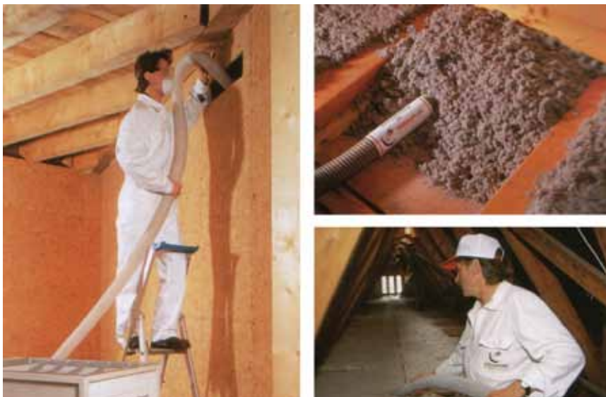
Ugrađivanje toplinske izolacije od celuloze u drvene elemente pasivne kuće
