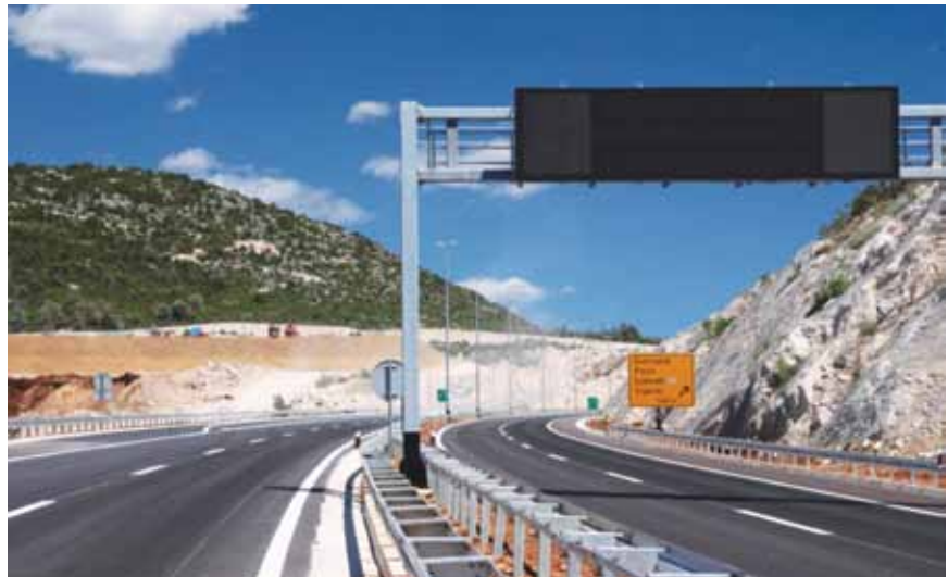
Dio autoceste na poddionici Ravča - Vrgorac
