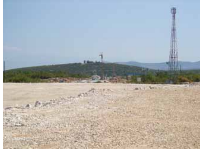
Sadašnji radovi u interregionalnom čvoru Metković
