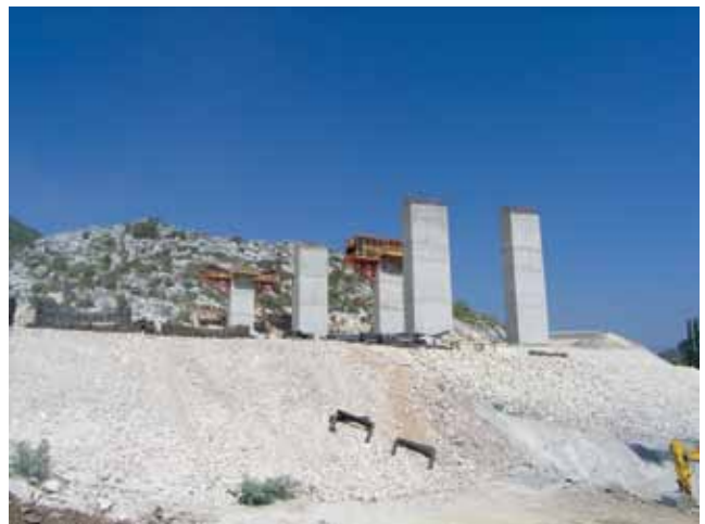
Stupovi vijadukta u spoju čvora Ploče s novom dionicom
