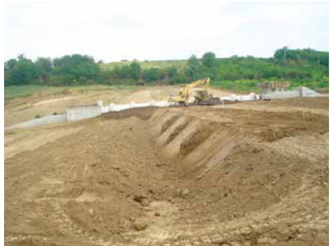
Nakon temeljnog ispusta počela se graditi nasuta brana
