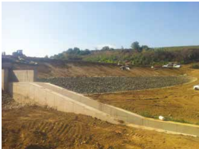
Bočni preljev i radovi na brani
