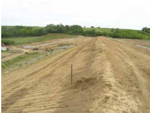
Gradilište brane tijekom posjeta
