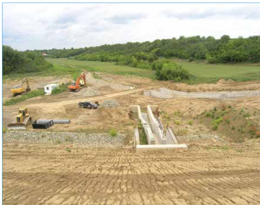
Temeljni ispus, bočni preljev i buduće korito potoka Čitluk
