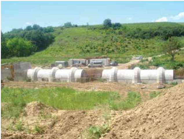
Početni radovi na brani i gradnja temeljnog ispusta
