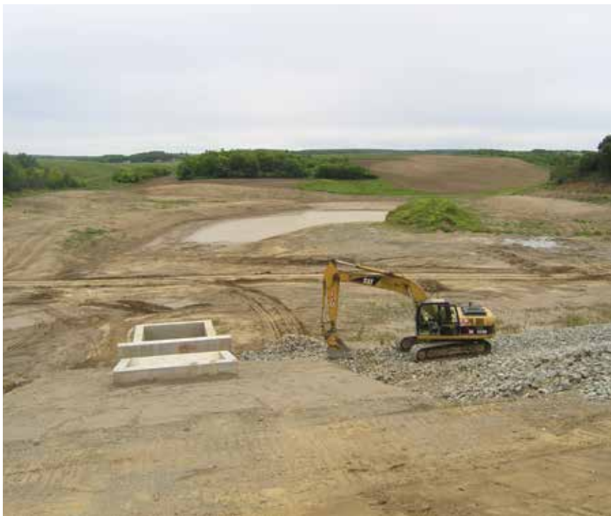
Prva voda u budućoj akumulaciji
