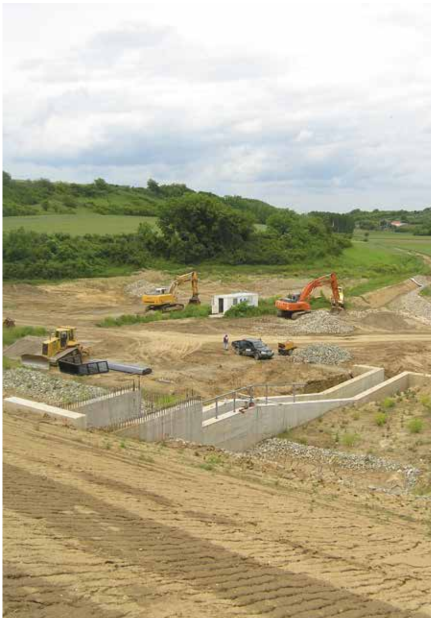
Gradilište brane tijekom posjeta
