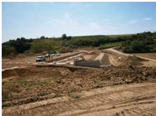
Radovi na brani početkom kolovoza 2012.
