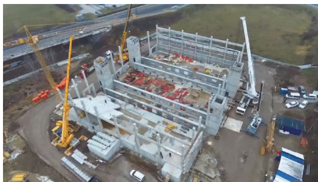
Slika 4. Dvorana Zeleni brijeg u Sisku tijekom izgradnje
