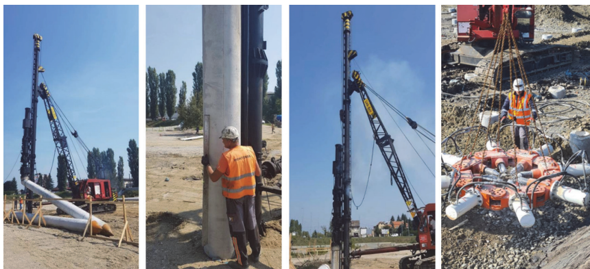
Slika 1. Tehnologija izvedbe zabijenih pilota (podizanje, pozicioniranje, zabijanje, uređenje glave pilota kliještima)
