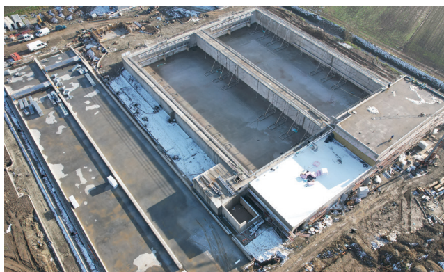
Slika 7. UPOV Đakovo tijekom izgradnje
