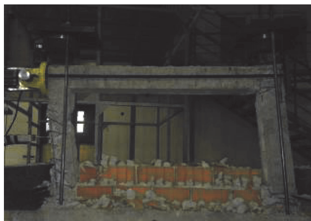
Slika 21. Oštećeni okvir s tradicionalnom ispunom pri najvećemu pomaku (omjer pomaka 0,08)
