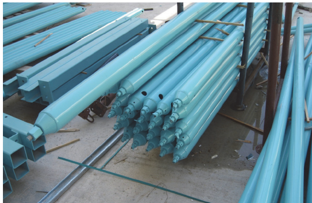
Slika 9. MERO elementi privremeno skladišteni na gradilištu
