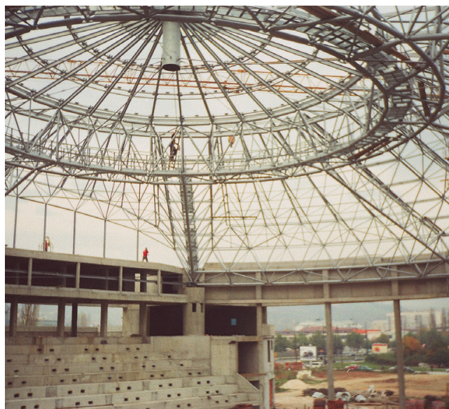
Slika 21. Prikaz dijela krovišta iz perioda montaže
