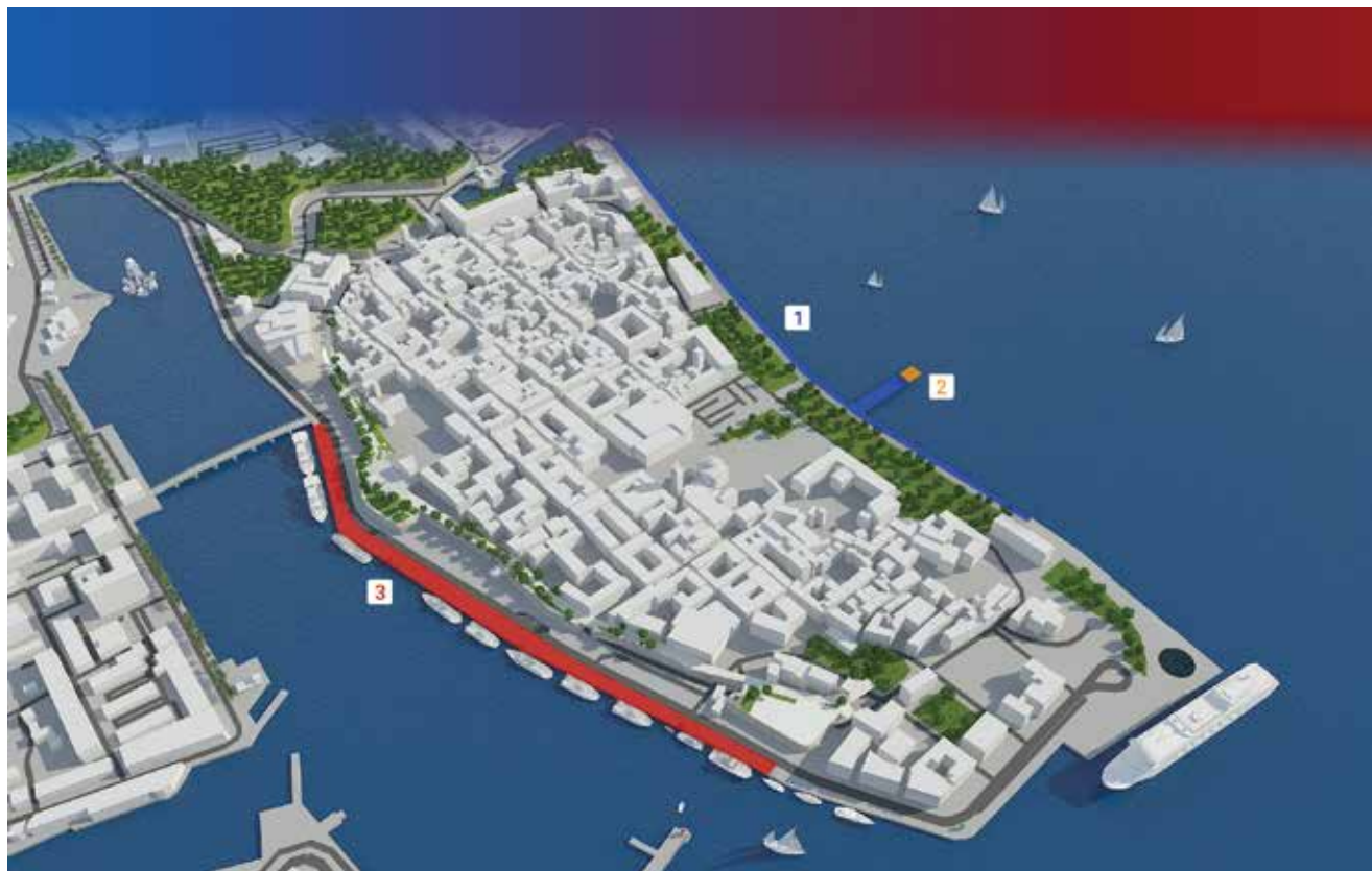
Projekt je obuhvatio rekonstrukciju obalnog zida Obale Petra Krešimira (1), rekonstrukciju gata (2) i Liburnske obale (3)
