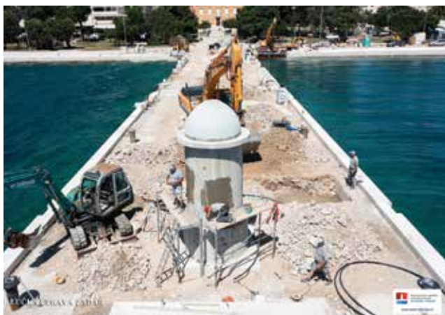
Radovi na rekonstrukciji gata
