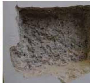
Jedna od brojnih građevinskih sonda postavljenih za ispitivanje zida
