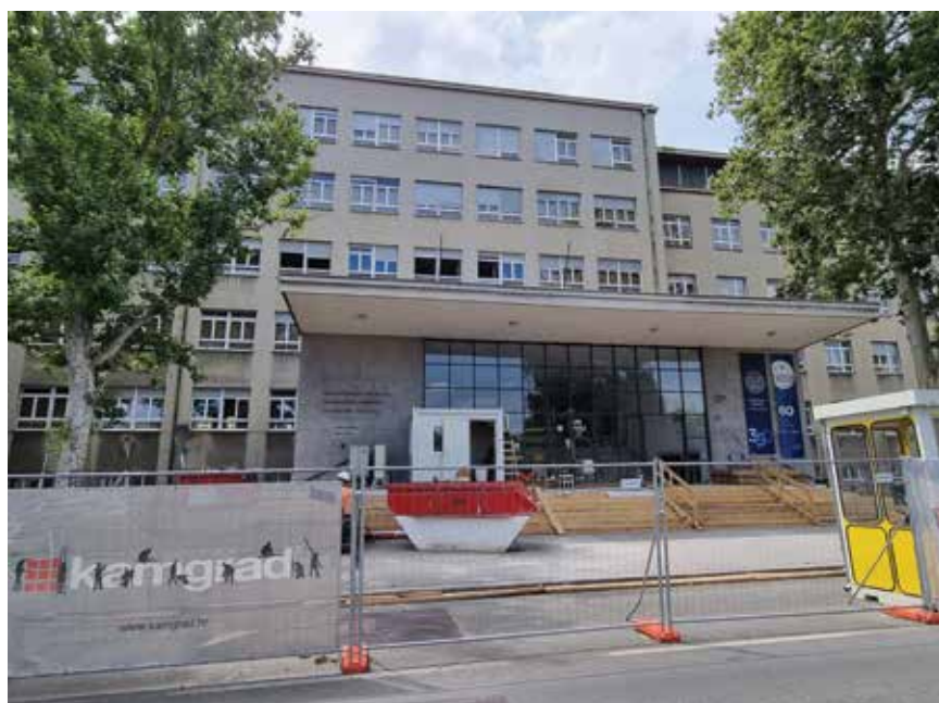
Pogled na gradilište glavne zgrade AGG fakulteta u Kačićevoj 26
