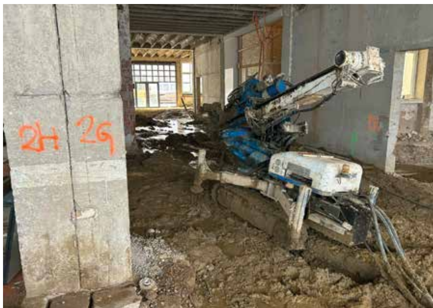
Detalj mlaznog injektiranja temelja tehnologijom jet grouting
