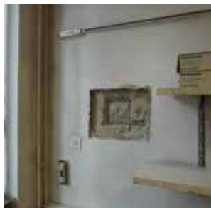
Mjesto ispitivanja armature u prizemlju
