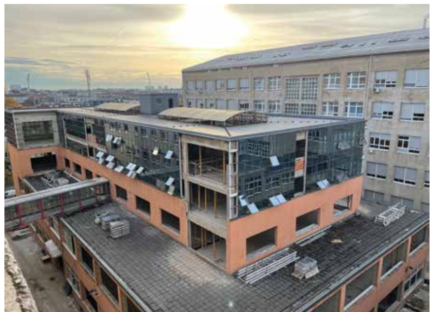
Radovi na dvorišnoj zgradi
