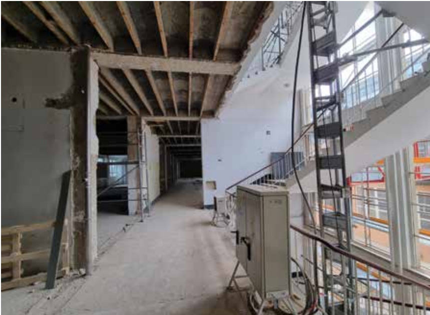
Detalj gradilišta uz stubište glavne zgrade (pomoćno)
