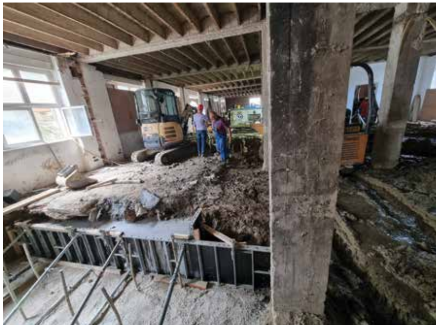
Radovi na ojačavanju temelja glavne zgrade
