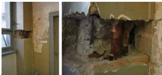
Ispitivanje armature stupa
