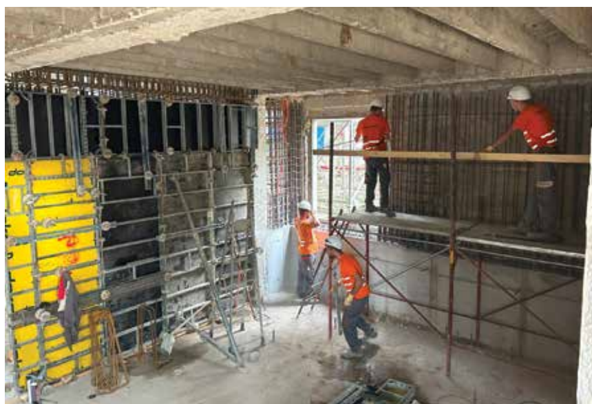
Radovi na ojačavanju zidova
