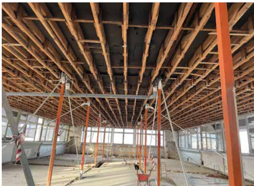
Pogled na gradilište na 5. katu glavne zgrade
