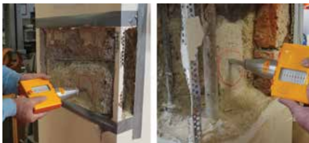
Ispitivanje betona sklerometrom
