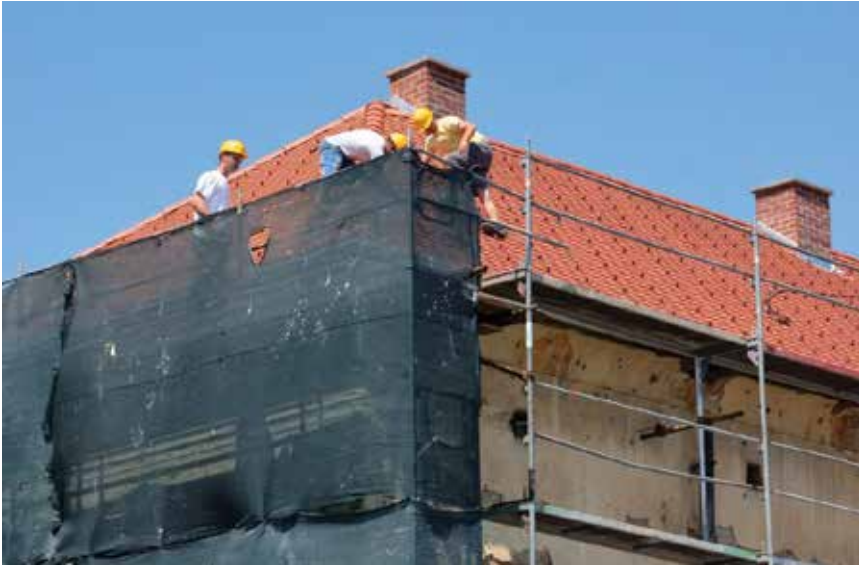
Energetska obnova rezultira značajnom uštedom godišnje potrebne toplinske energije (Foto: PIXELL)
