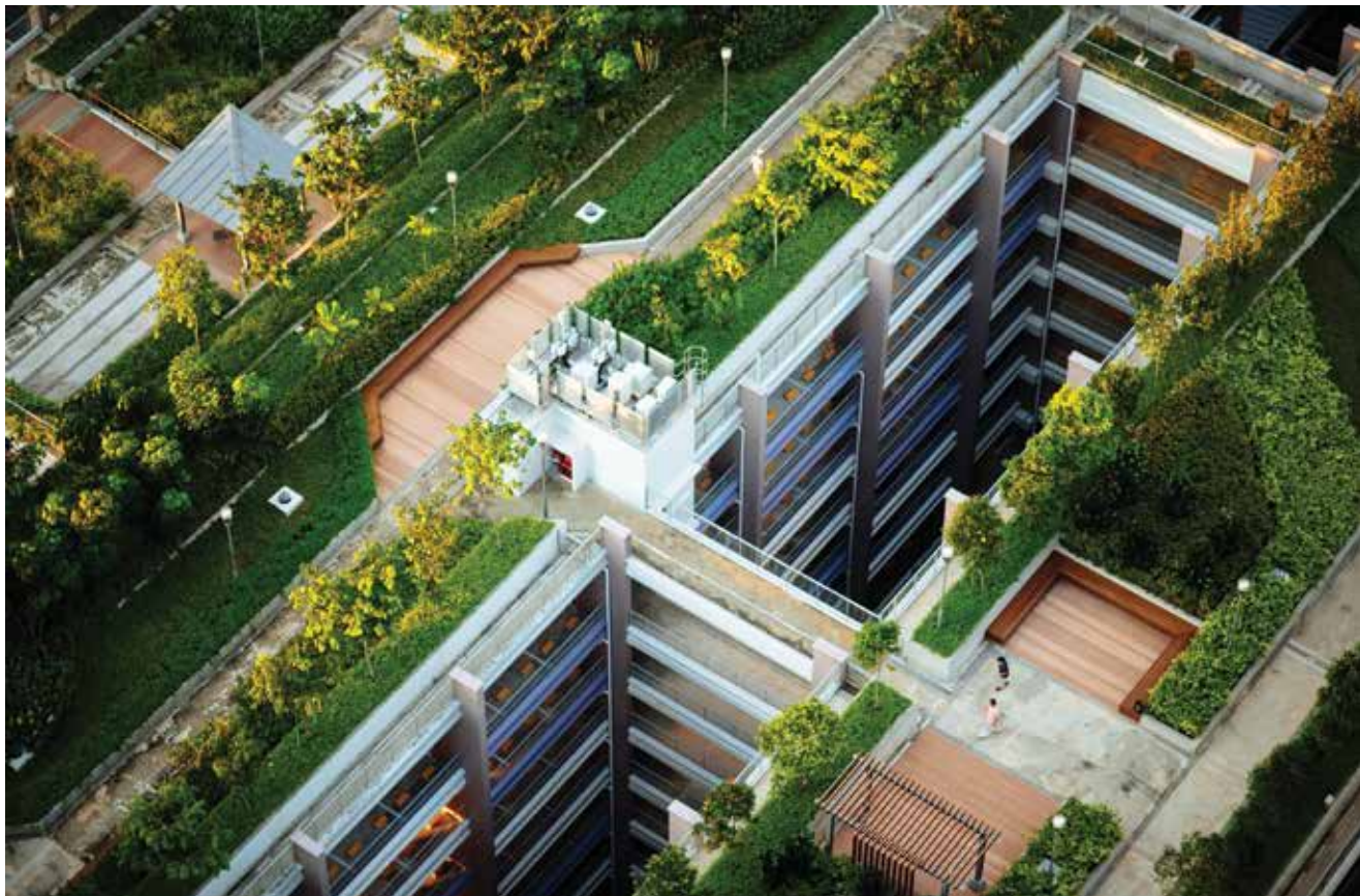
Razvoj zelene infrastrukture temelj je održivog prostora
