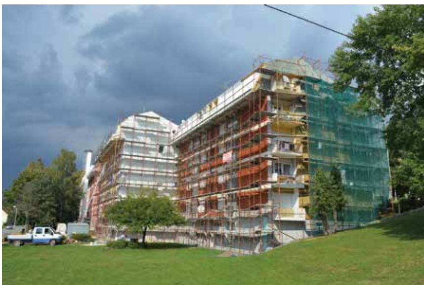
Energetska obnova višestambene zgrade
