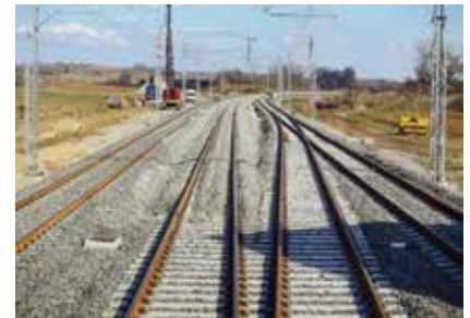
Modernizacija i gradnja nizinske pruge Zagreb-Rijeka mogla bi završiti 2035. (Marko Todorov / CROPIX)
