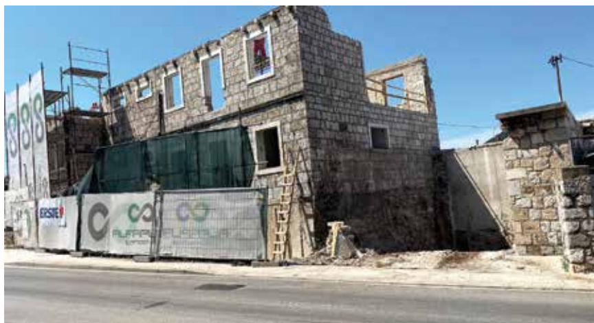
Detalj s gradilišta snimljen nakon uklanjanja dotrajalog krovišta i svih stropnih konstrukcija
