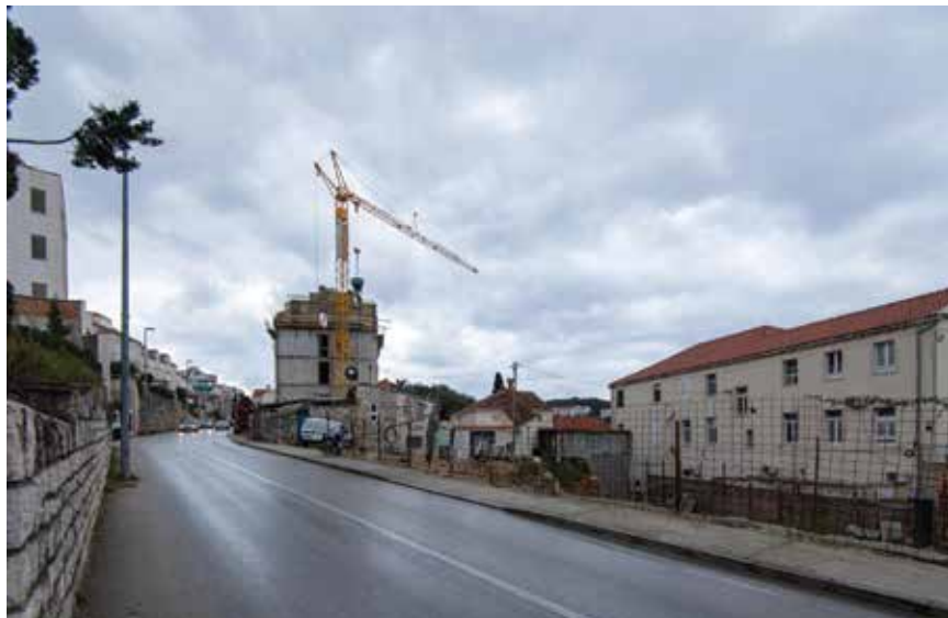
Gradilište je bilo vrlo skućeno za manevriranje građevne mehanizacije
