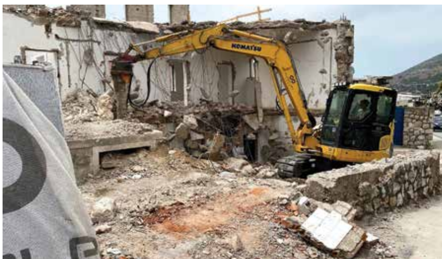
Uklanjanje dijela postojeće građevine
