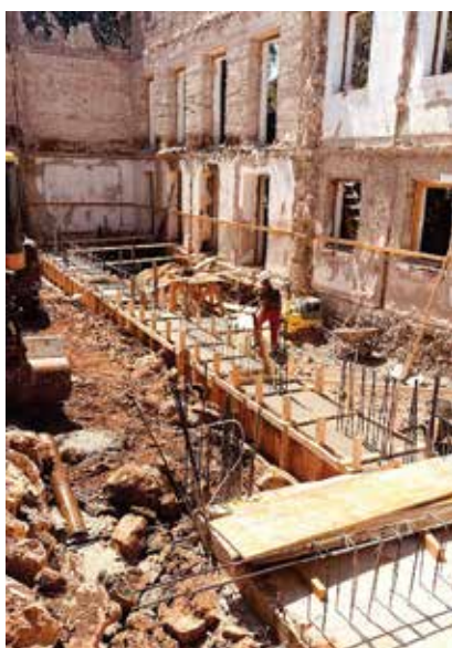
Betoniranje temelja
