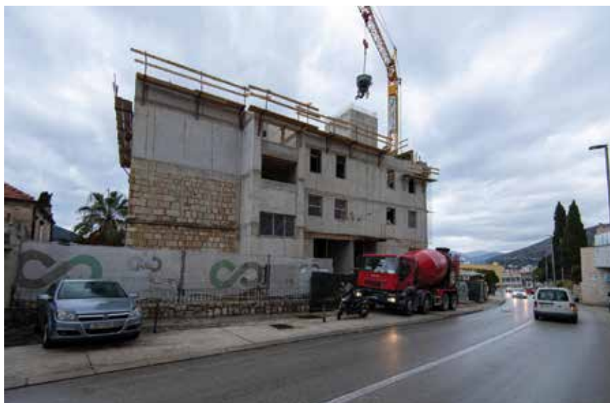
Detalj s gradilišta
