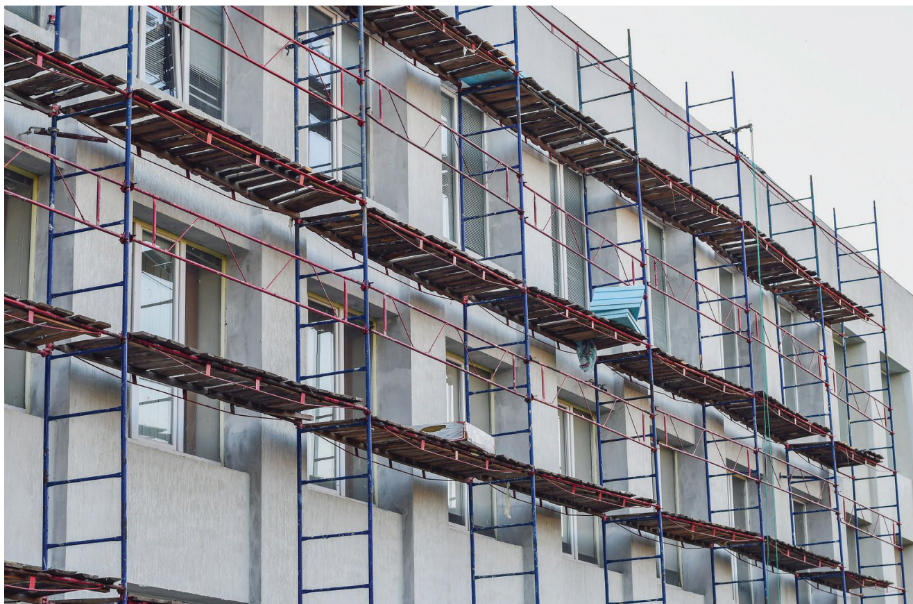
Natječaj za energetska obnova zaustavljen je zbog prekoračenja osiguranih sredstava (Foto: HSZG)
