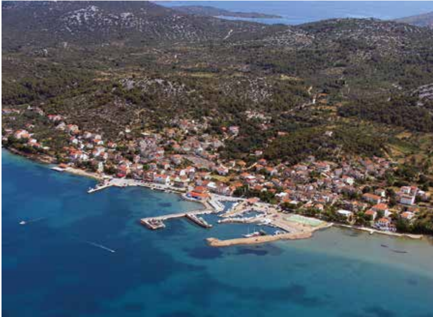
Pogled na luku Tkon prije dogradnje
