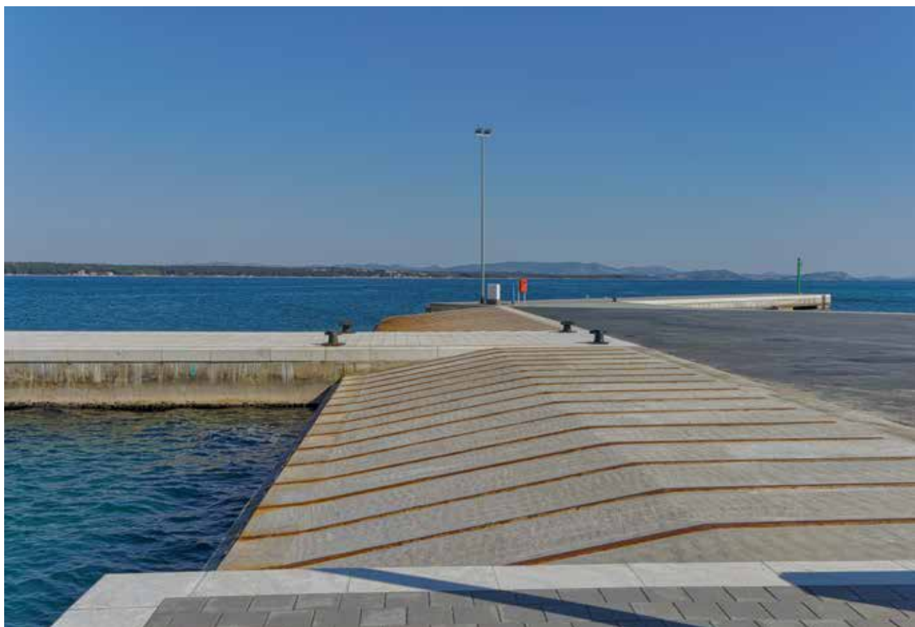
Pogled na betonsku rampu za pristajanje trajekta
