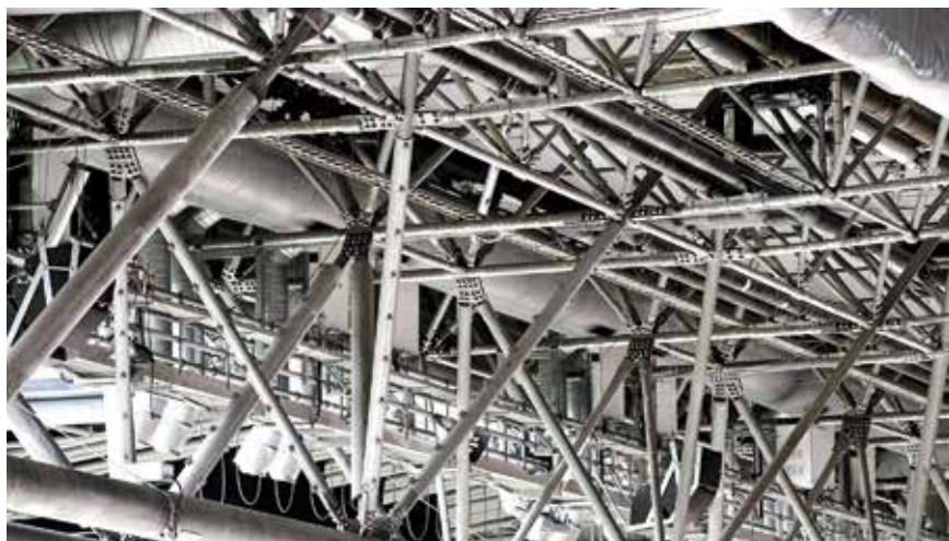
Stadion Parken – pogled na međusobno preklapanje krovne čelične rešetkaste konstrukcije s instalacijama
