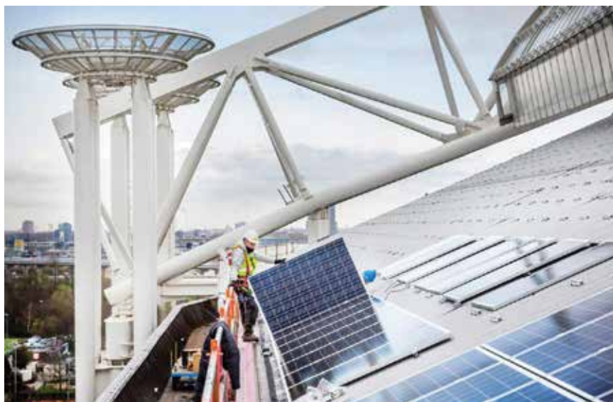
Postavljanje fotonaponskih panela na krovnu konstrukciju Johan Cruyff Arene
