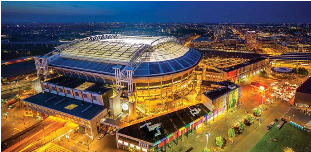
Pomični krov Johan Cruyff Arene u Amsterdamu u doba izgradnje bio je relativna novost
