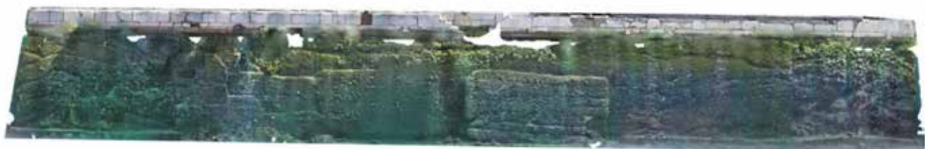
Fotogrametrija zida Adamićeva gata u Rijeci dužine 50 metara i dubine sedam metara (izvor: Vectrino d.o.o.)
