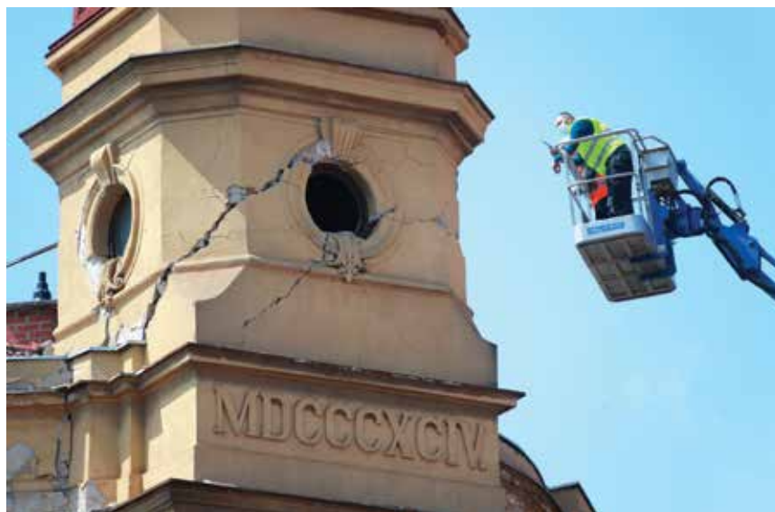
Nakon novog potresa 23. travnja 2020. stanje kupole i tornja postalo je još kritičnije, zbog čega se pristupilo njihovom kontroliranom uklanjanju
