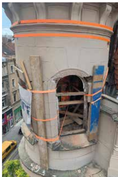
Raspucali toranj fiksiran je uz pomoć zatega i dodatne drvene konstrukcije te ojačan FRP vlaknima s unutarnje strane
