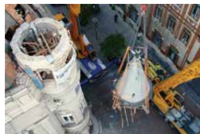
Detalj s gradilišta tijekom skidanja kupole
