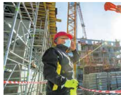
Ulazak na gradilište i izlazak s gradilišta treba odvojiti po skupinama
