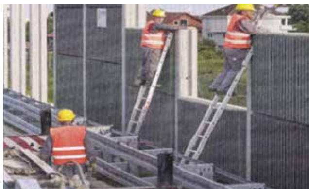
Slika 23. Barijera za zaštitu od buke tipa Ruconbar (Hrvatska)
