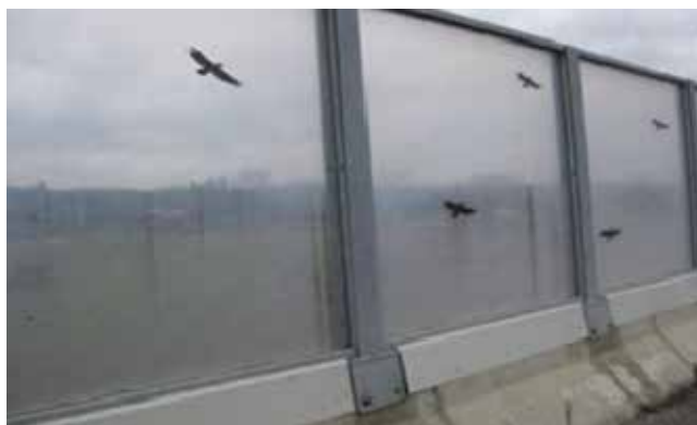
Slika 20. Barijera za zaštitu od buke na obilaznici oko Skopja
