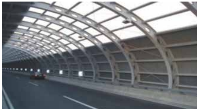
Slika 18. Izvedba galerija za zaštitu od buke
