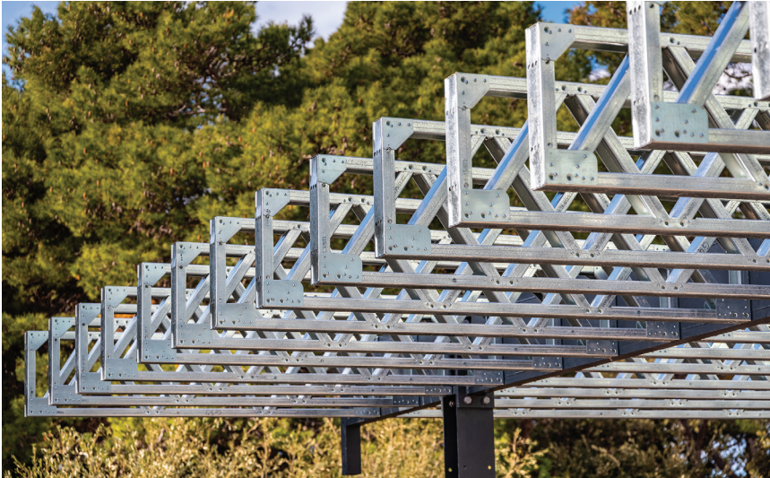
Detalj s gradilišta
