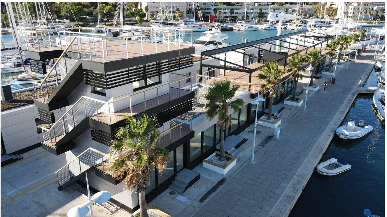
Novi terminal u ACI Marini nakon završetka svih radova
