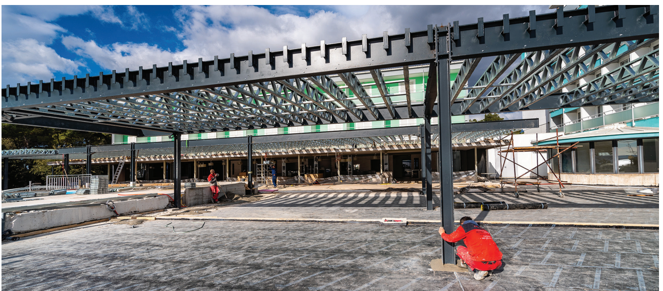
Prednosti industrijskog načina građenja su brzina, kvaliteta, čisto gradilište i suha gradnja, što se odnosi i na izvedbu temelja
