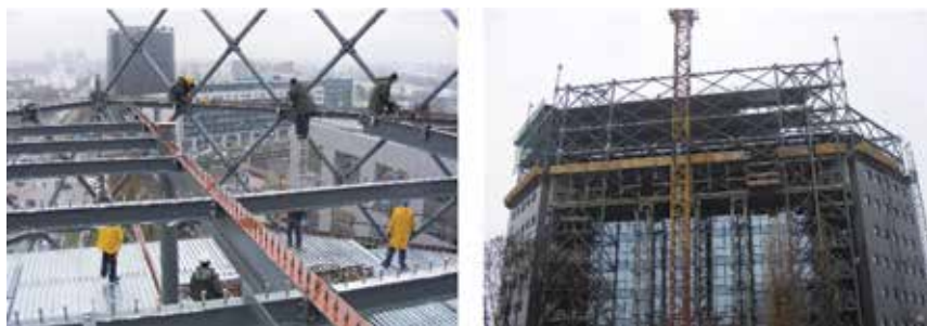
Slika 3. Vertikalna nadogradnja - zgrada Euroherc, Zagreb
