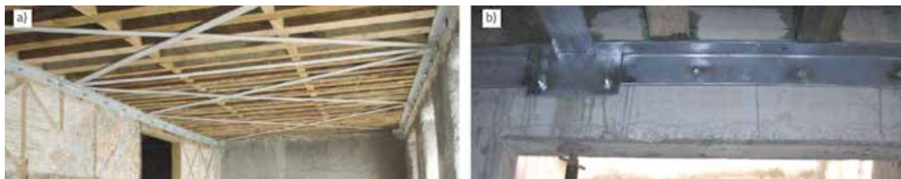
Slika 11. Ojačanje drvene međukatne konstrukcije čelikom: a) Ojačanje pomoću križno raspoređenim čeličnih zatega; b) Spoj između međukatne konstrukcije i zida
