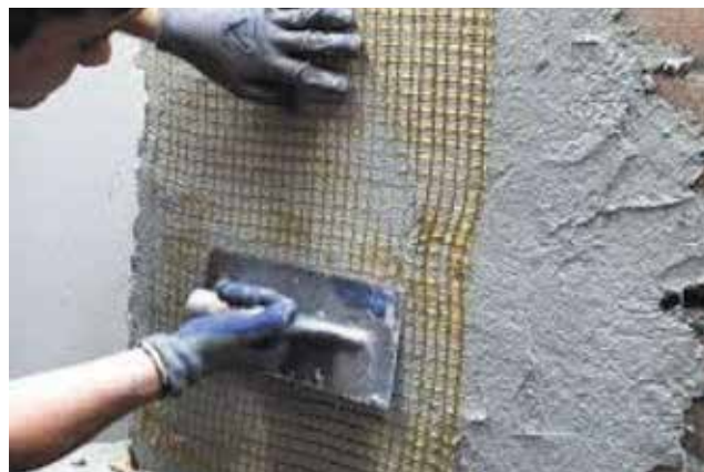
Slika 5. Nanošenje TRM-a [26]
