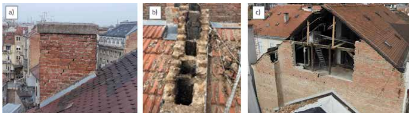
Slika 17. Rušenja dimnjaka i lastavice zabatnoga zida (autor fotografija: Mario Todorčić, [39])
