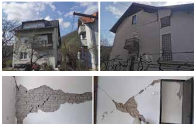
Slika 29. Oštećenja kuće u MO Dankovec, GČ Gornja Dubrava (autor fotografija: Luka Božić i [39])
