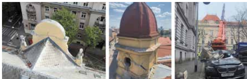
Slika 21. Oštećenje ukrasnih elemenata (autor fotografija: Mario Todorčić i [39])
