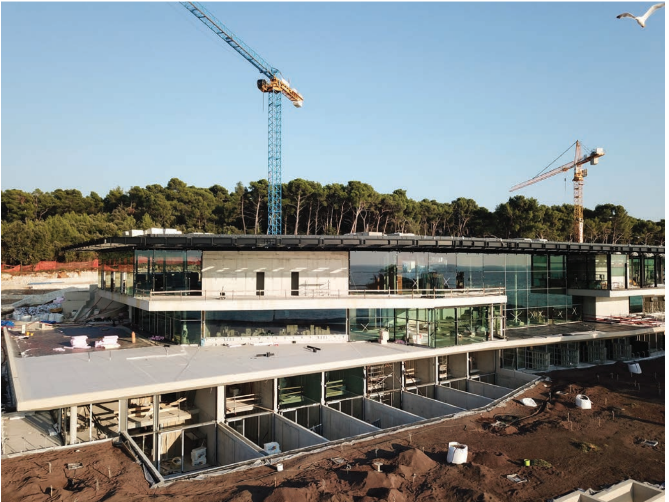
Pogled na kongresnu dvoranu u kojoj je postavljena staklena stijena dimenzija 15 x 3,5 m
