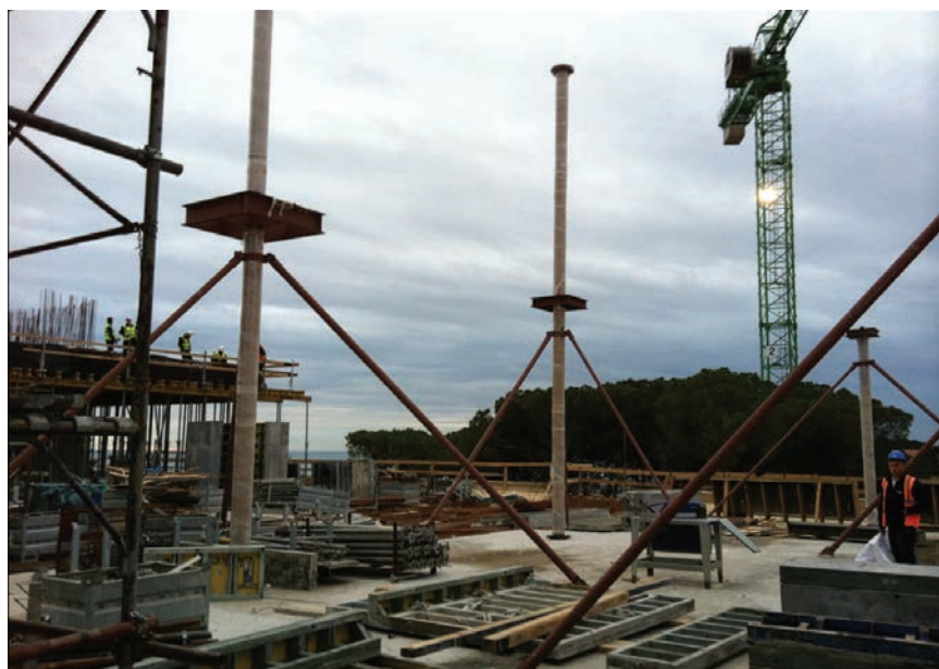
Montaža spregnutih stupova (čelik – beton)
