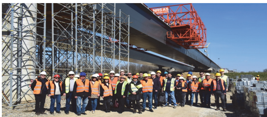
Sudionici obilaska gradilišta zainteresirano prate prezentaciju i postupak izgradnje mosta
