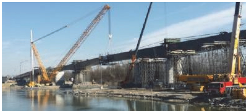
Za spajanje mosta na rijeci Savi kod Svilaja iskorišten je pad vodostaja
