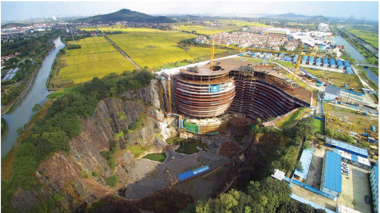
Pogled na gradilište
