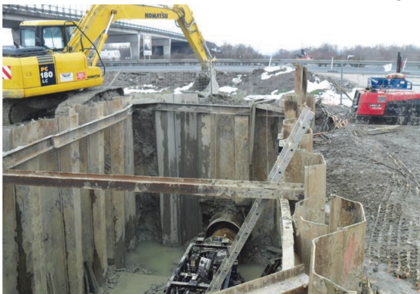
Gradnja magistralnog cjevovoda Kosnica – Cerje (bušenje ispod autoceste)
