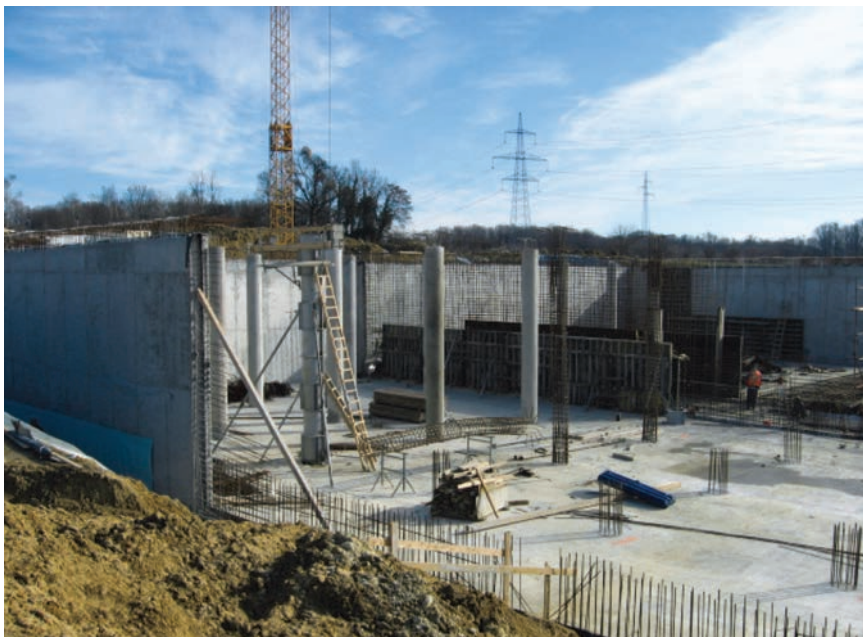
Gradnja vodospremnika Cerje
