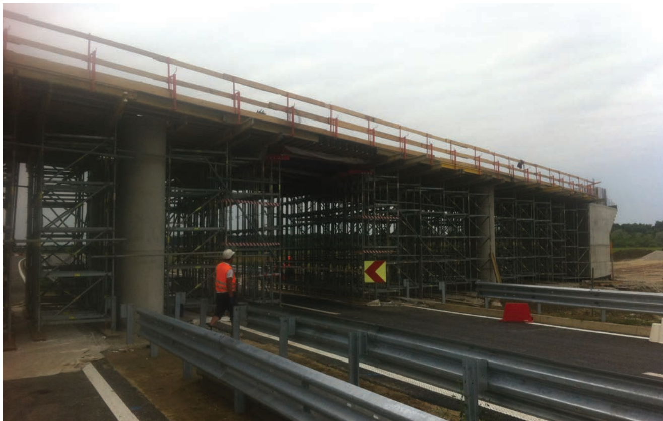
Detalj s gradilišta
