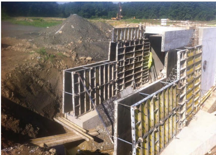
Detalj gradnje propusta
