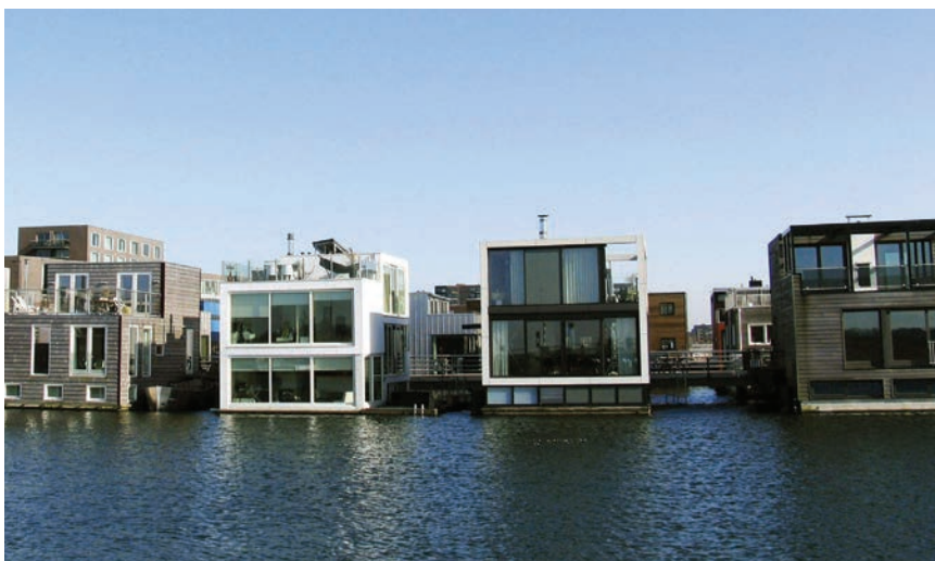
Niz plovećih kuća u Rotterdam
