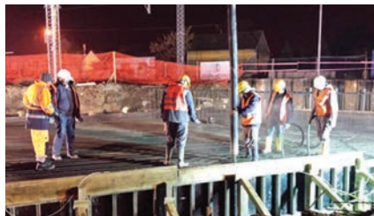
Radovi na betoniranju gornje ploče podvožnjaka
