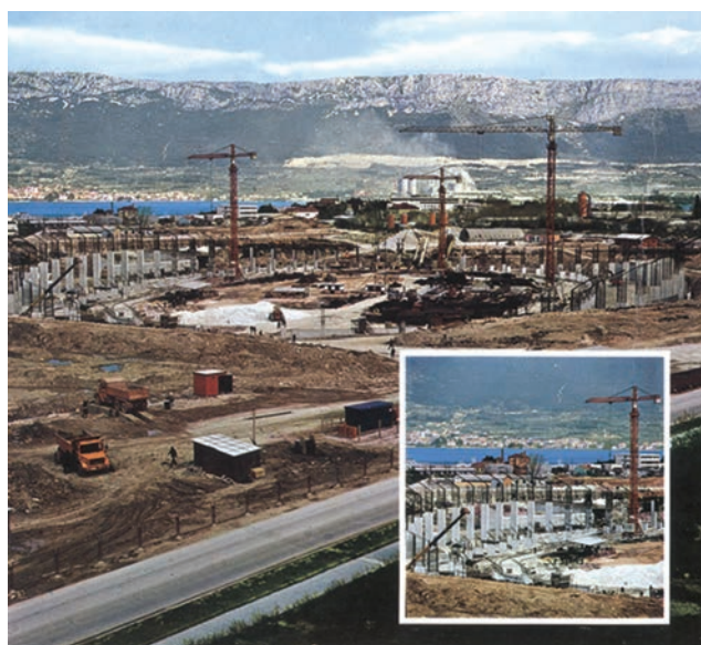
Detalj s gradilišta stadiona Poljud, ožujak 1978.
