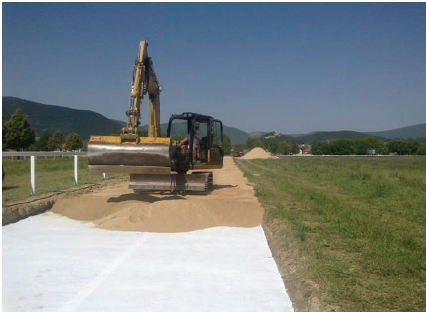
Detalj s gradilišta
