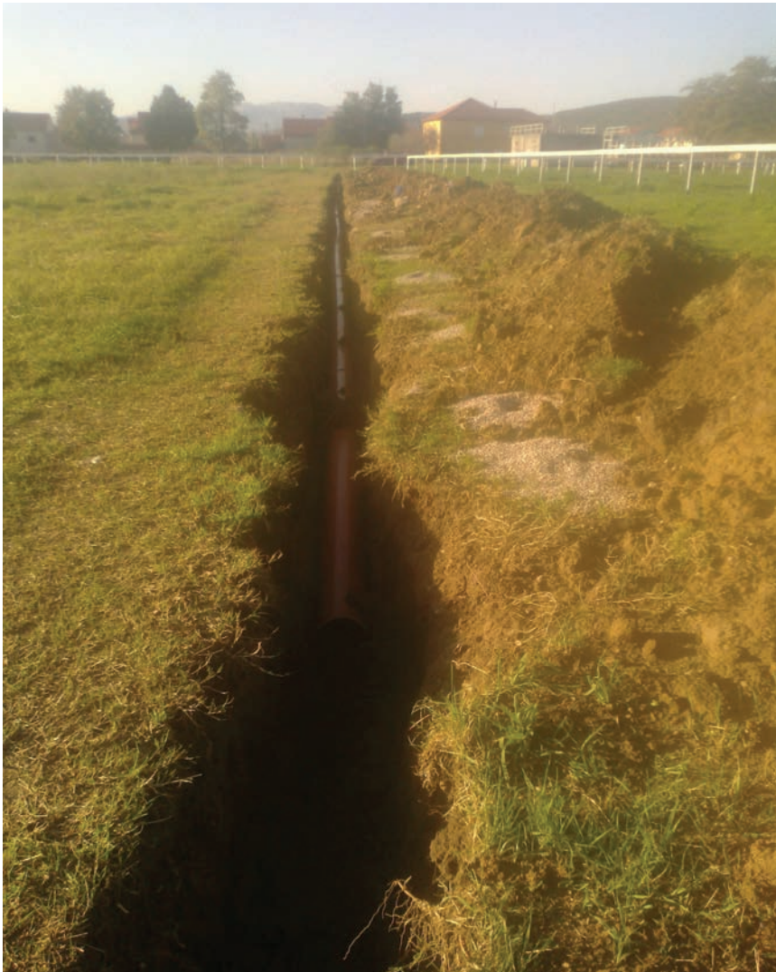
Polaganje cjevovoda za odvodnju vode s parkura
