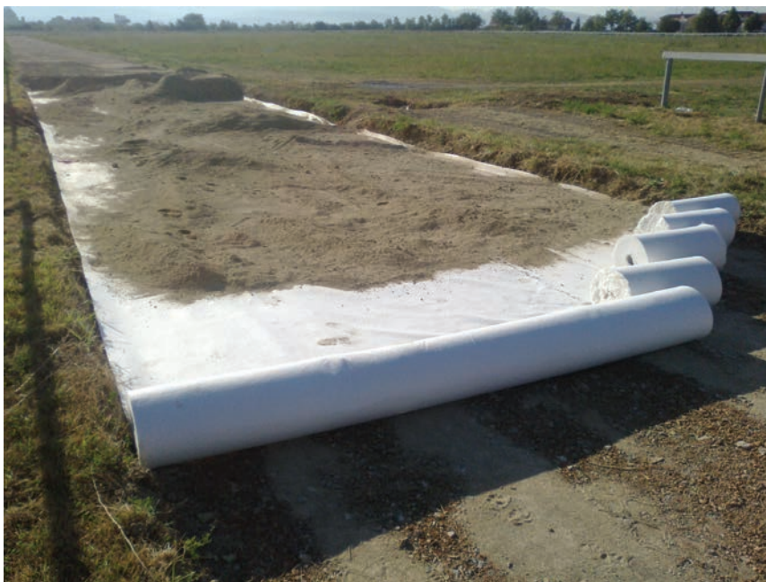
Polaganje geotekstila na trkaćoj stazi
