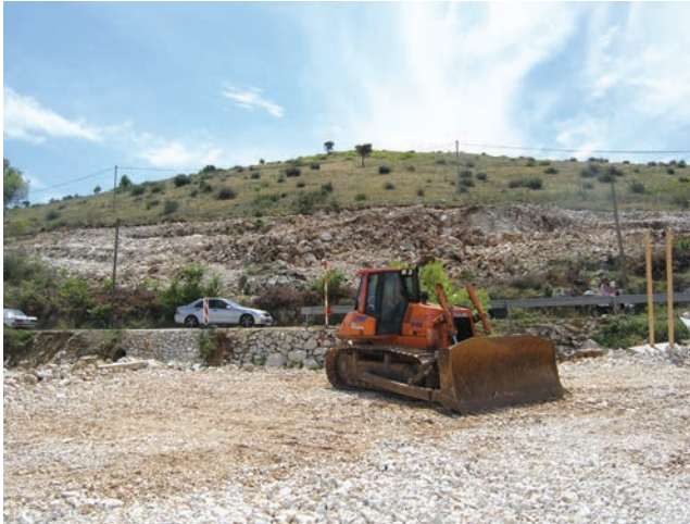
Radovi na čiovsjoj strani mosta
