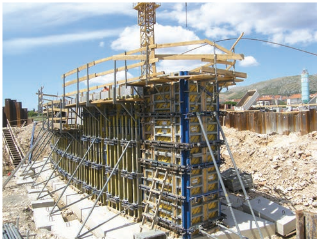
Pripreme za betoniranje jednog stupa
