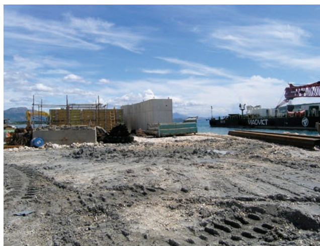
Detalj gradilišta tijekom obilaska
