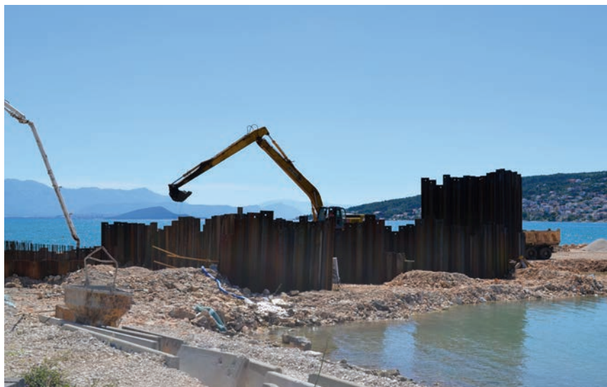
Čelične talpe za zaštitu građevne jame stupišta
