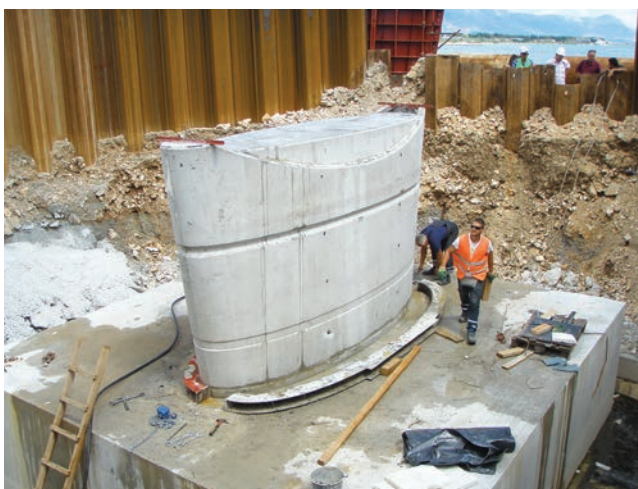
Jedan izbetonirani stup
