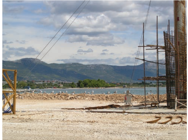
Detalj gradilišta – u pozadini ornitološki i ihtiološki rezervat Pantan
