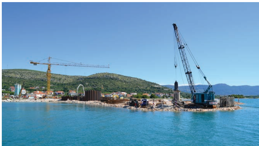
Radovi na sjevernoj strani mosta
