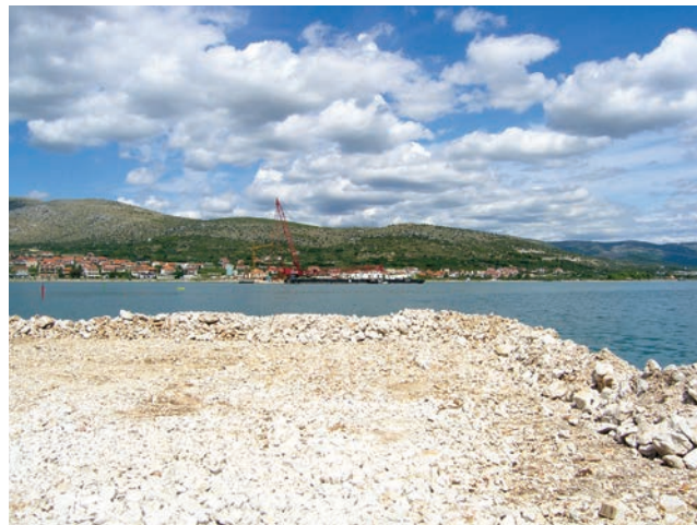
Pogled na gradilište s čiovske strane
