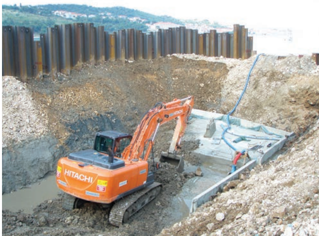
Iskopi u građevnoj jami
