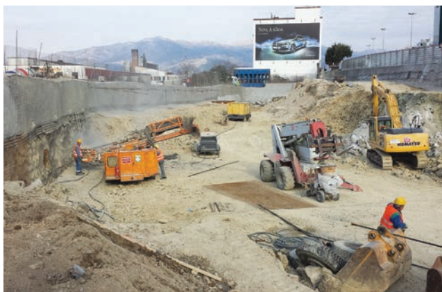
Iskopi i zaštita građevne jame
