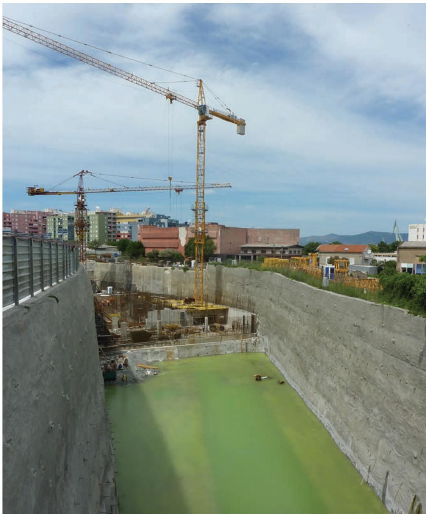
Pogled na gradilište sa suprotne strane
