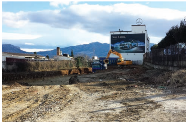
Početak iskapanja građevne jame
