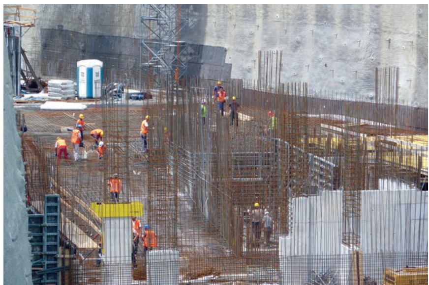
Armiranje podnih ploča i zidova
