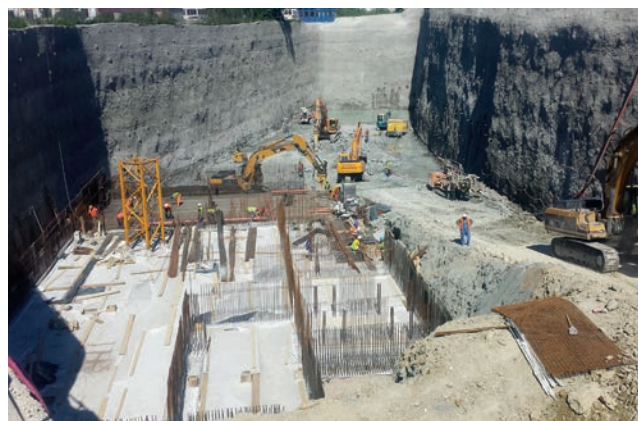
Temeljenje i početak betonskih radova u građevnoj jami
