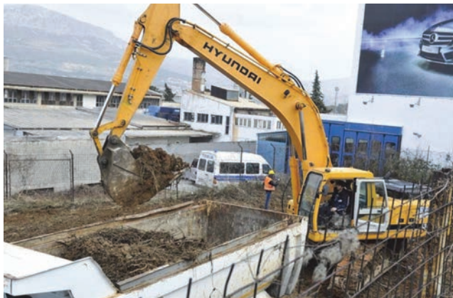
Čišćenje terena i početak iskopa
