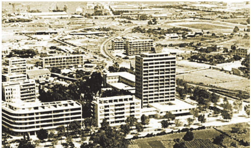
Pomgradov neboder tijekom građenja
