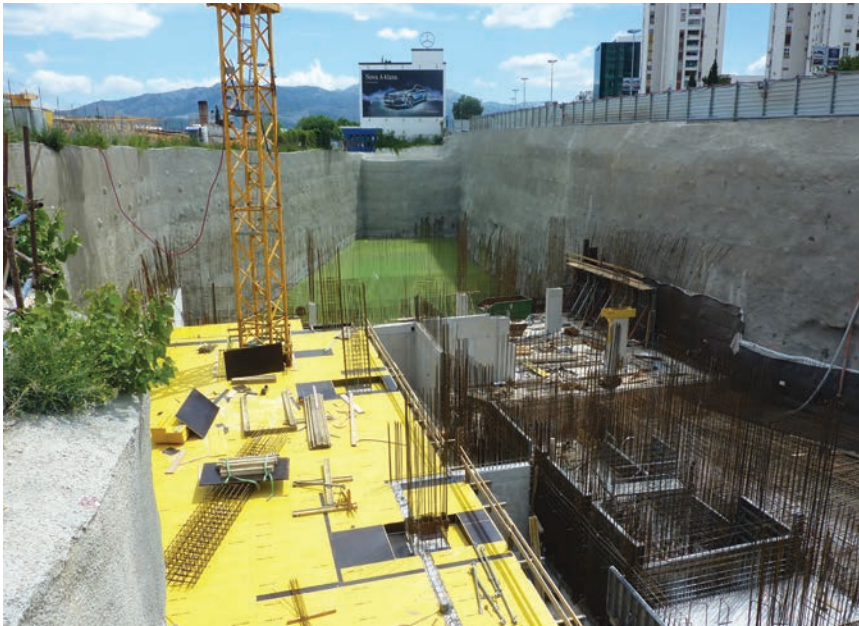
Detalj gradilišta tijekom obilaska
