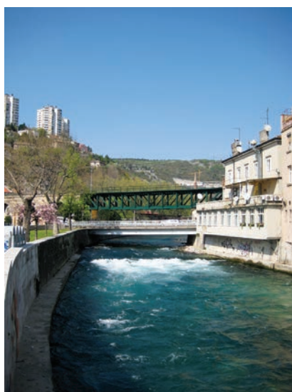
Željeznički i cestovni most preko Rječine u Rijeci
