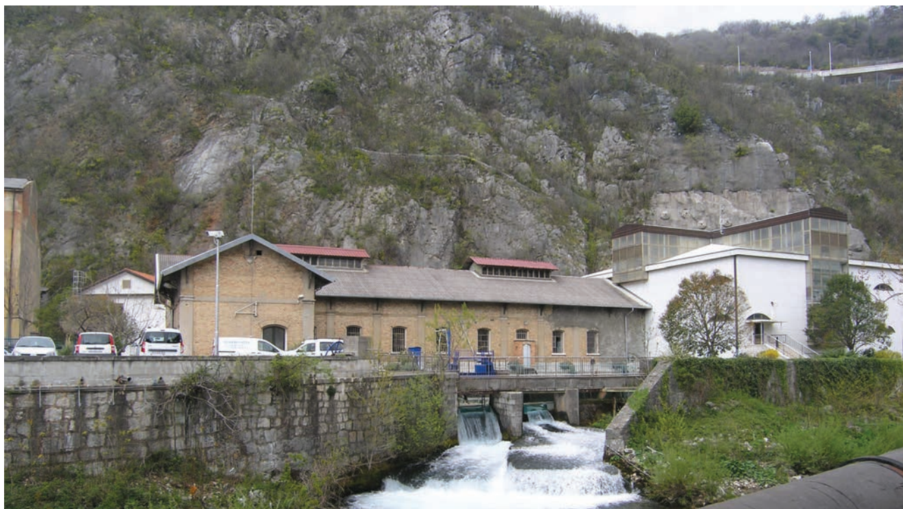
Stara zgrada vodocrpilišta Zvir
