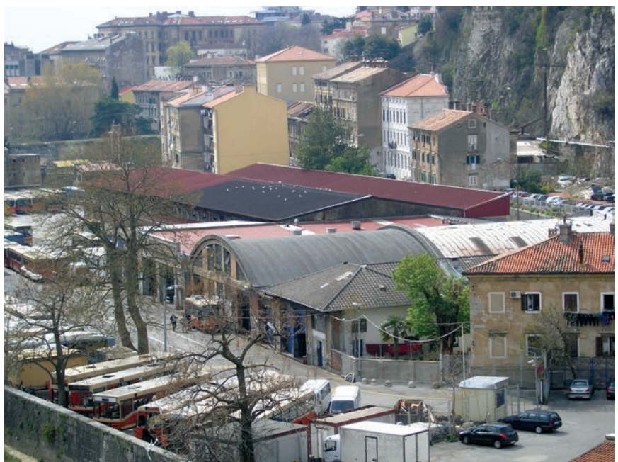
Hangari negdašnje tramvajske remize i sadašnje automehaničarske radionice Autotroleja
