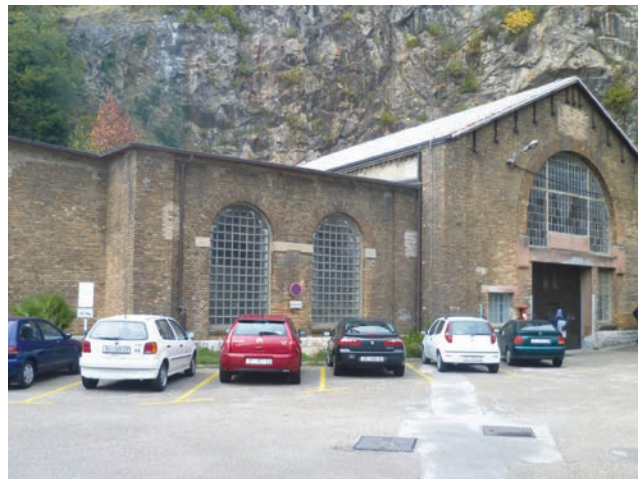
Pogonska zgrada Spalionice smeća
