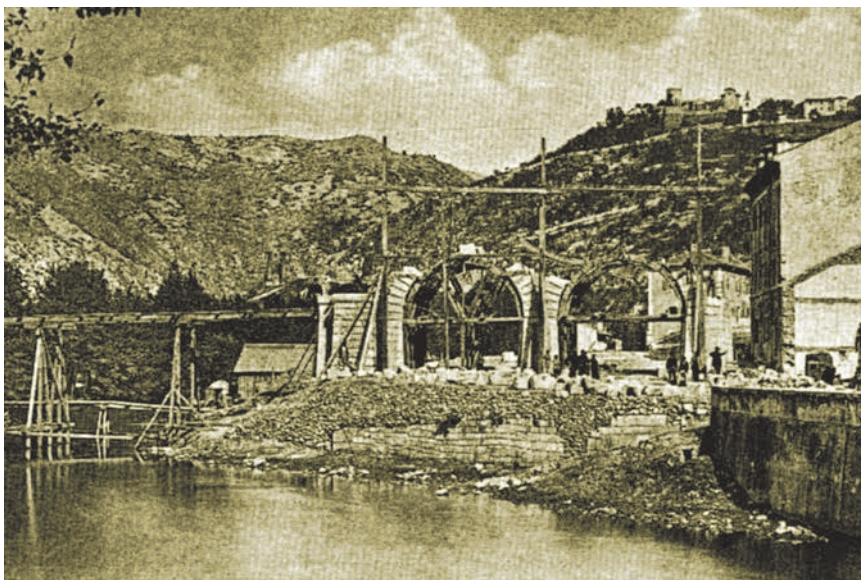
Gradnja željezničkog mosta preko Rječine u Rijeci
