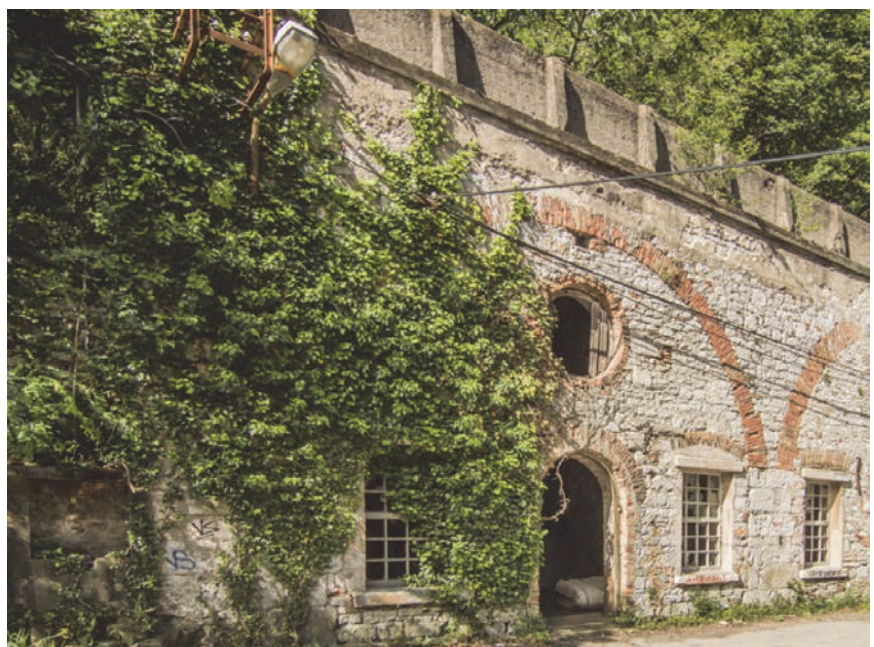
Dio najstarijih pogonskih zgrada
