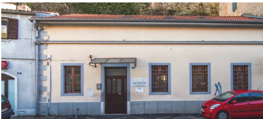
Zgrada u Ružičevoj ulici u kojoj je nekad bila Tvornica sapuna Heindlhofer
