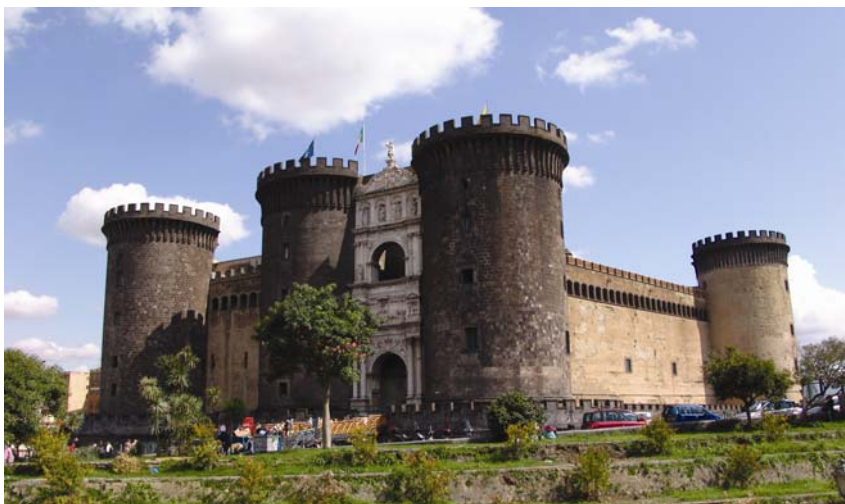
Slika 2. Dvorac Nuovo (Napulj, Italija) izgrađen od blokova zeolitnog tufa
