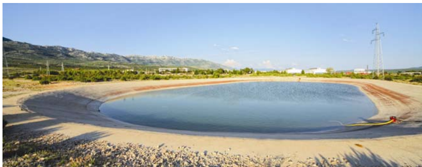
Sanacija velikog bazena je u tijeku
