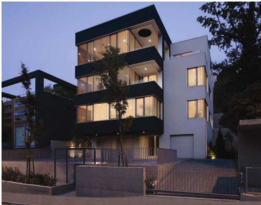
Stambena građevina u Istarskoj ulici u Zagrebu
