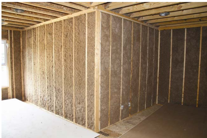
Zidovi obloženi izolacijom od celuloze
