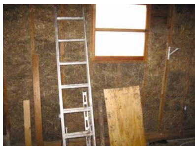
Postavljanje izolacije od slame
