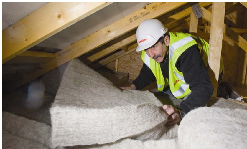
Ugradnja izolacije od ovčje vune u potkrovlju
