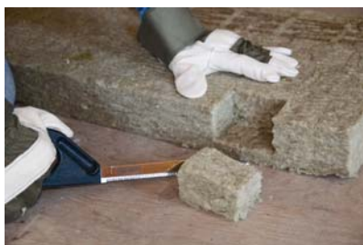
Rezanje izolacije od ovčje vune
