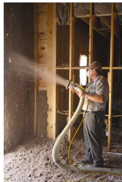
Prskanje izolacije od celuloze
