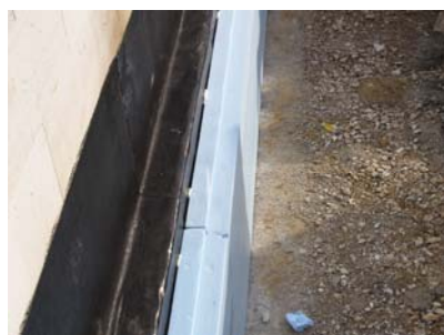
Slika 3. Izvedba toplinske izolacije trakastog temelja
