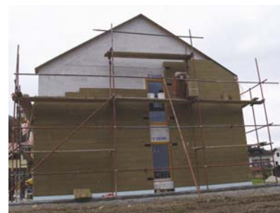
Slika 10. Pričvršćivanje sidrenih elemenata
