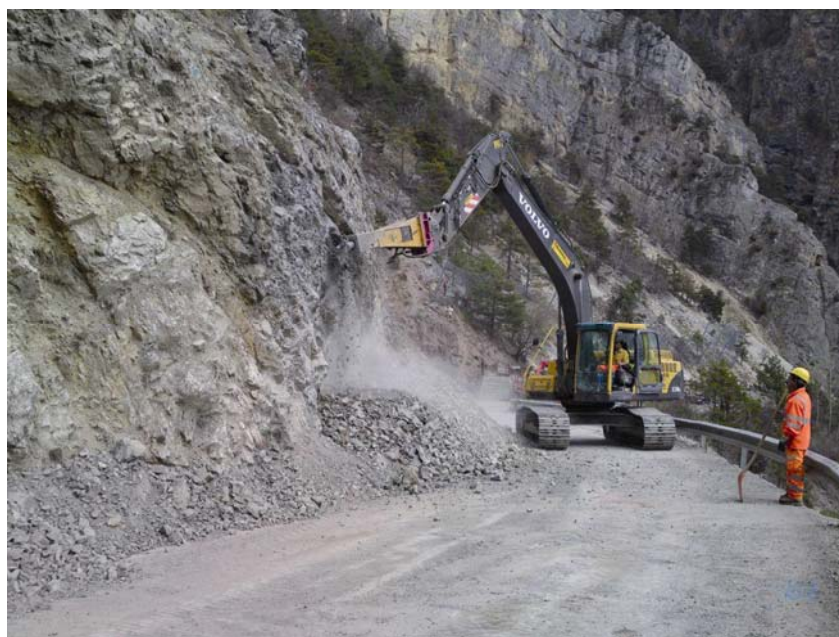
Pripremni radovi na zaštitnoj galeriji
