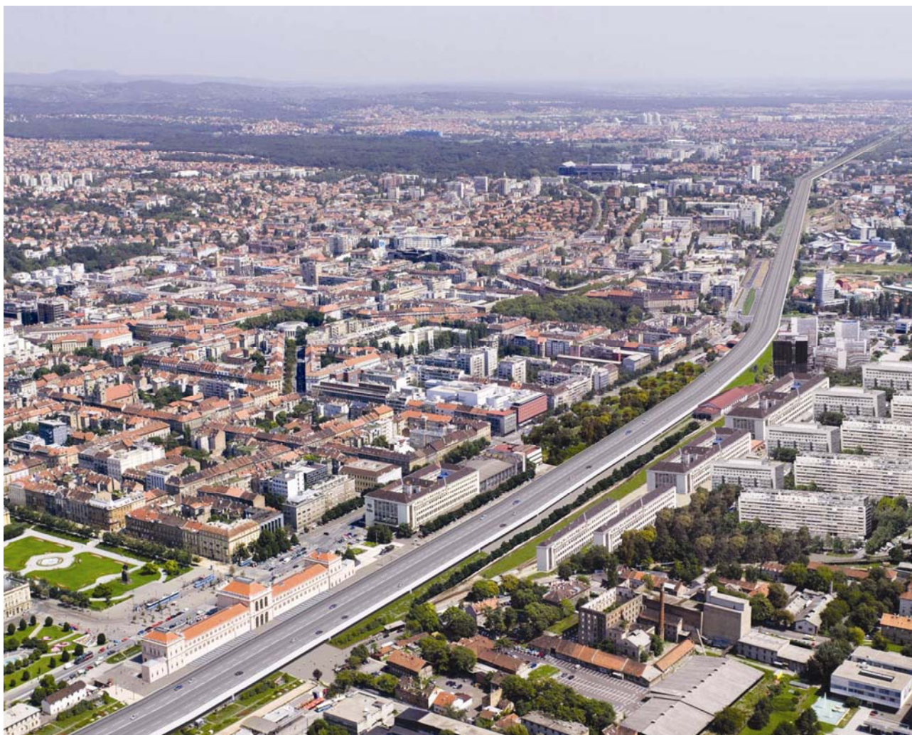
Slika 7. Panoramski pogled na brzu gradsku cestu na vijaduktu u koridoru postojeće željezničke pruge
