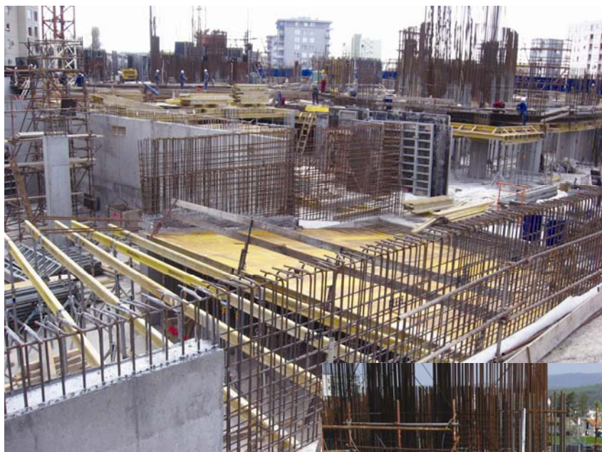
Građevinski radovi u razini tla početkom 2009.
