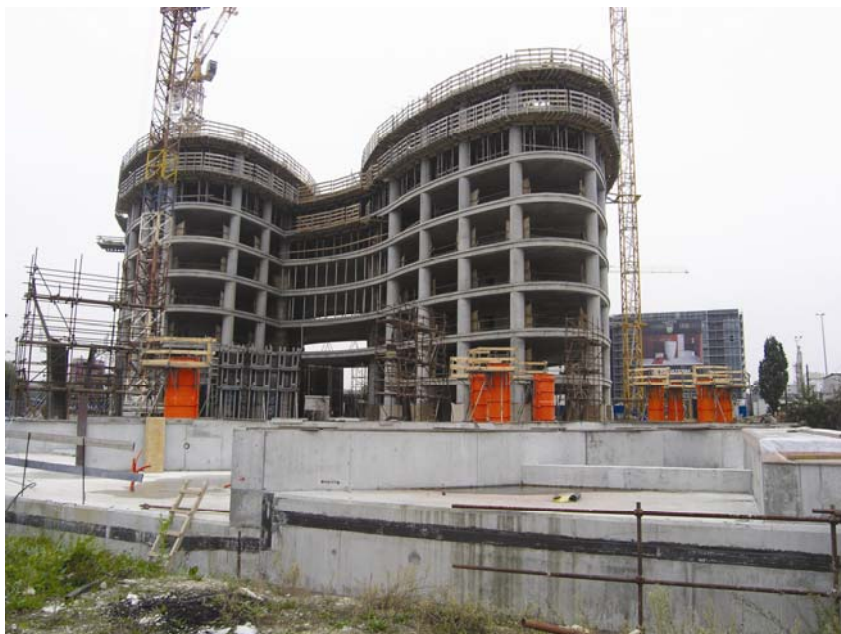
Gradilište snimljeno tijekom posjeta
