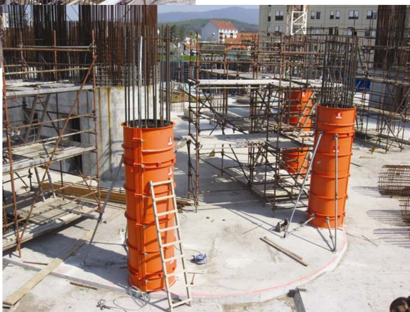
Armiranje i oplata okruglih stupova
