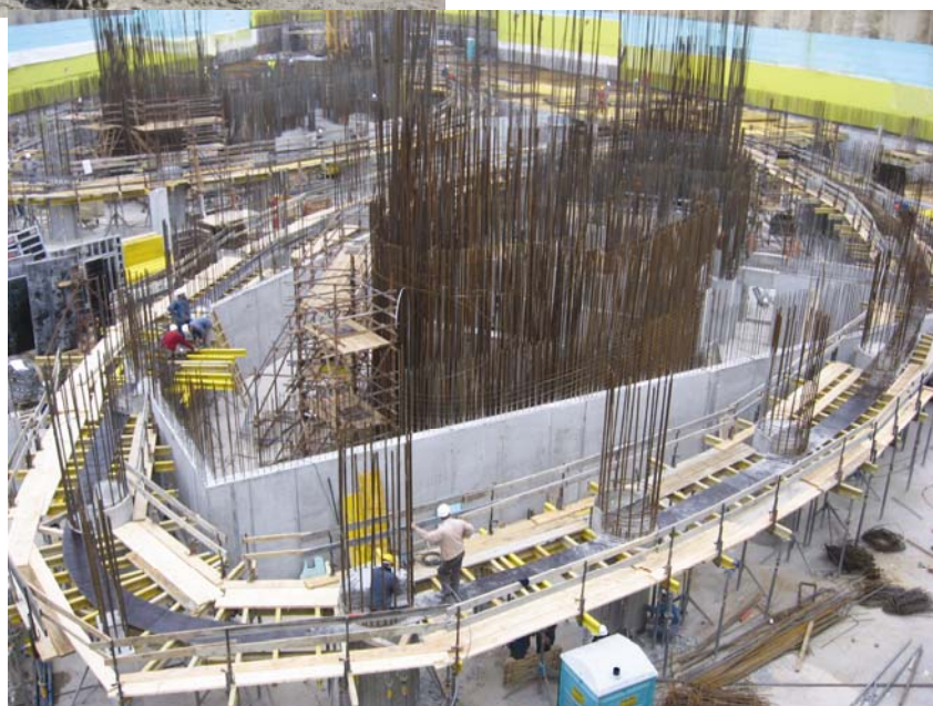
Početak betoniranja armiranobetonske jezgre
