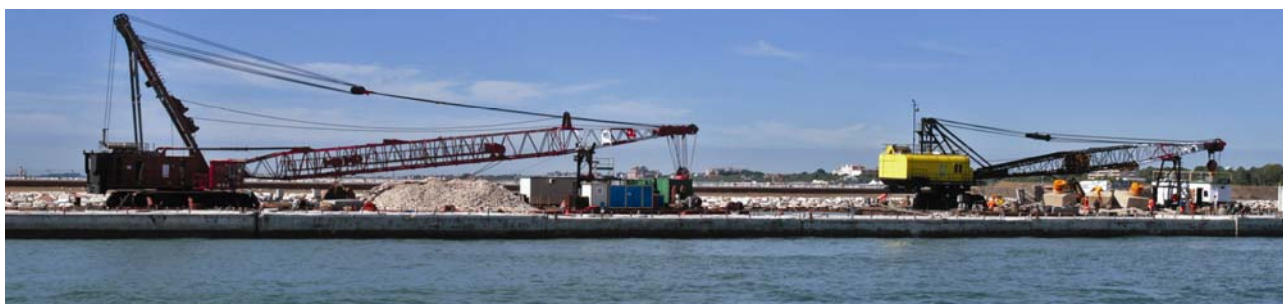
Pogled na dio gradilišta
