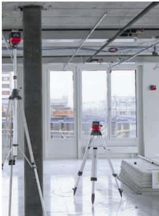
Izvedba stropa pomoću nivelira
